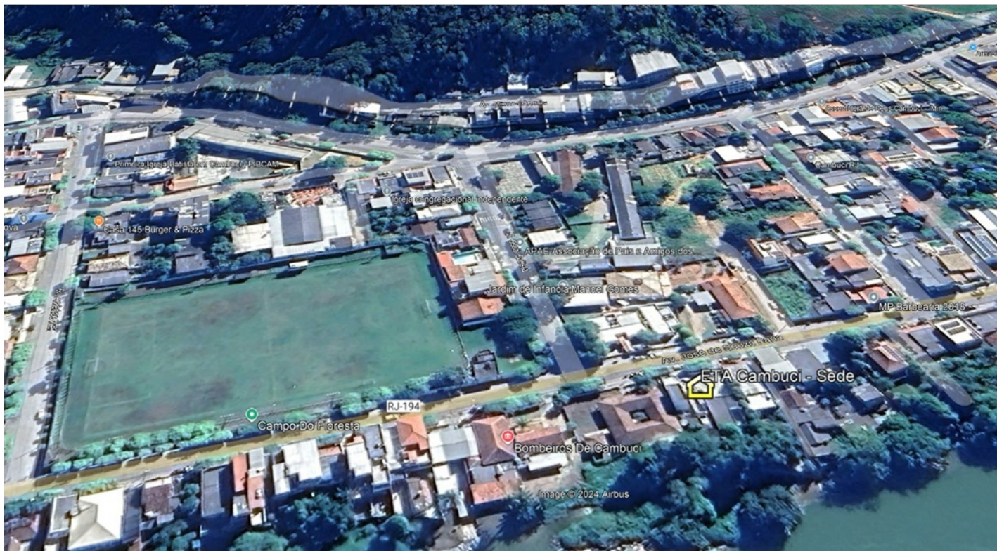
Foto 1 – Localização da Captação e ETA Cambuci
