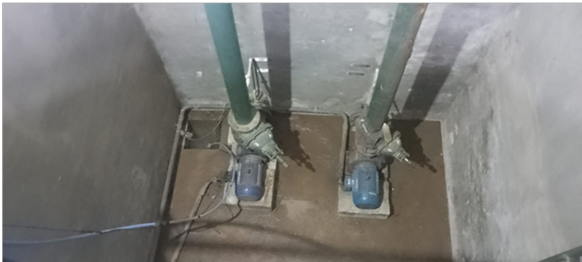
Fotos 4 – Conjuntos moto-bomba trocados para segurança operacional
