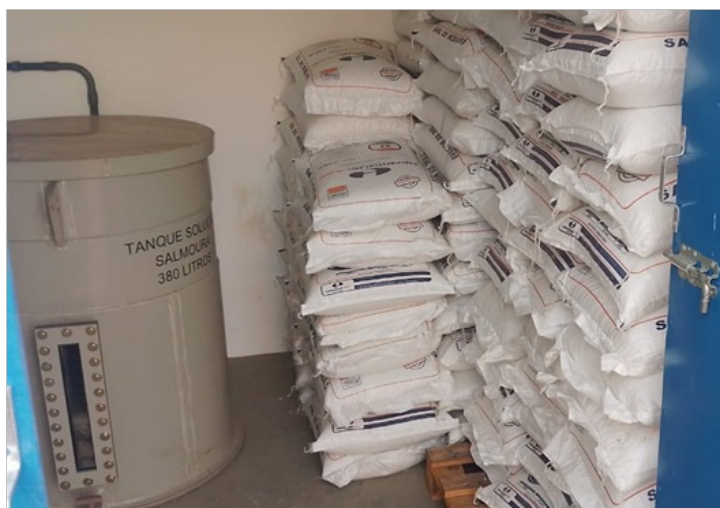
Foto 17 – Unidade de produção de Hipoclorito de sódio a partir da eletrólise da salmora
