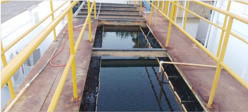
Foto 10 – Vista do decantador, que havia sido lavado
