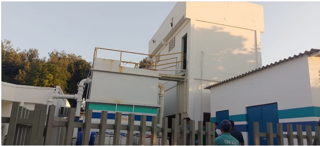
Foto 2 – Vista da ETA Cambuci
