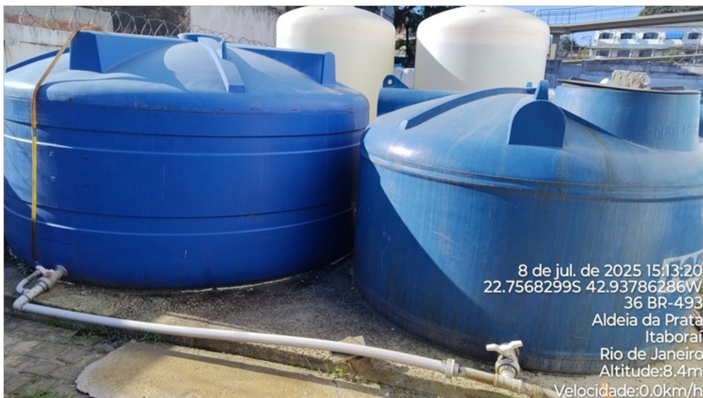
Foto 14 - Armazenamento do Sulfato de alumínio.
