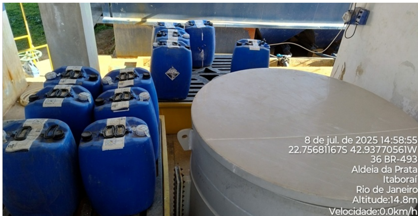
Foto 17- Armazenamento do ácido fluossilícico.
