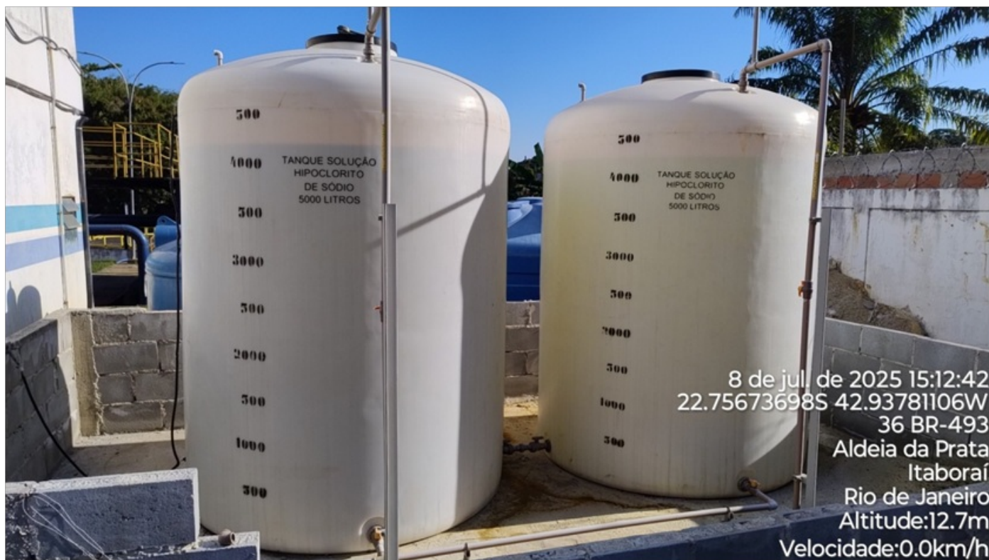
Foto 16 - Tanques de armazenamento de Hipoclorito de sódio.
