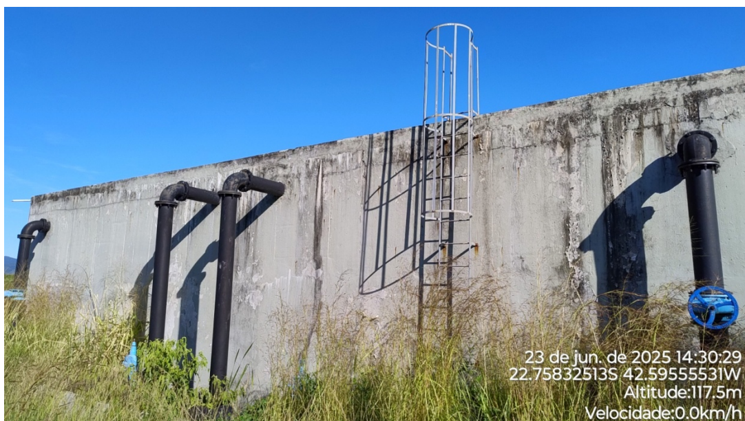
Foto 04 – Vista das tubulações de entrada, recalque e escada de acesso ao topo.
