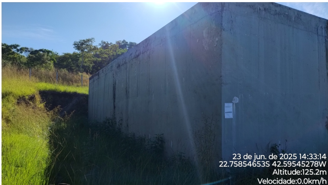
Foto 08 – Vista lateral da estrutura.
