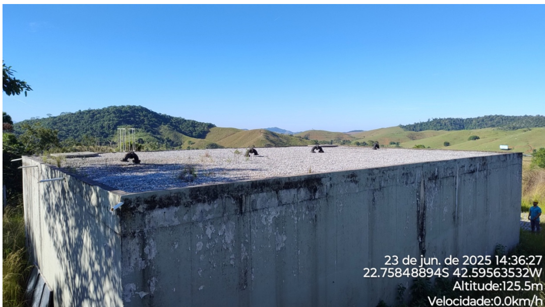
Foto 09 – Laje superior do reservatório e dutos de ventilação.
