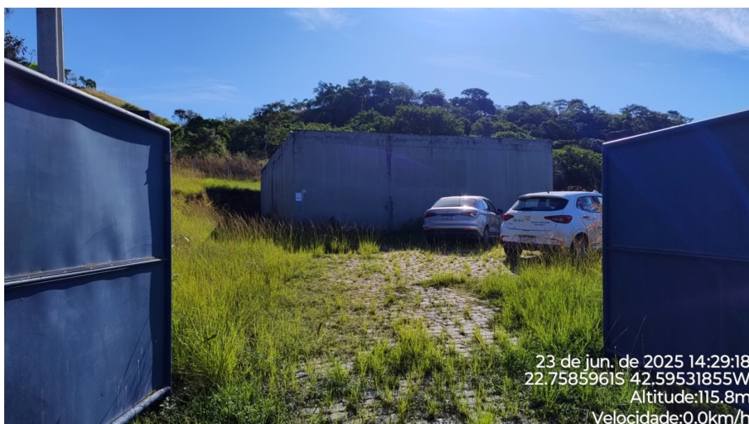
Foto 02 – Pátio de acesso ao reservatório.
