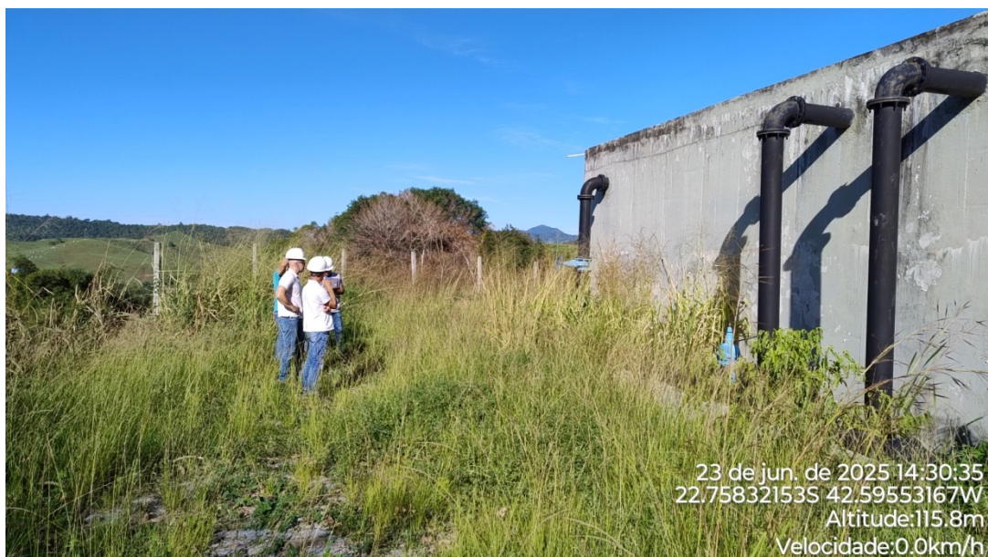
Foto 04 – Vista das tubulações de entrada, recalque e escada de acesso ao topo.
