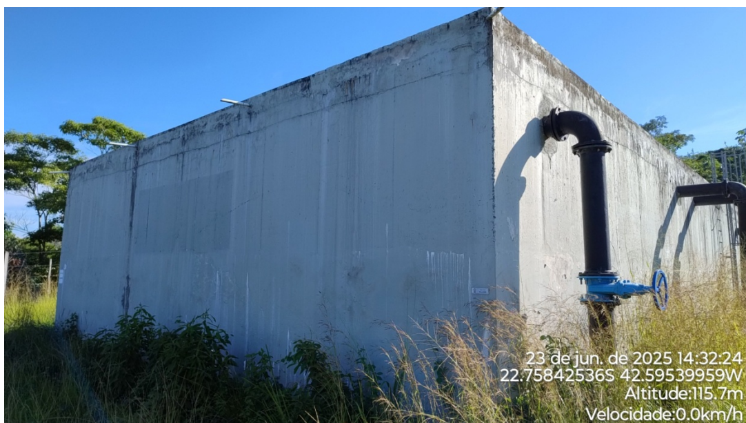
Foto 07 – Vista lateral da estrutura.
