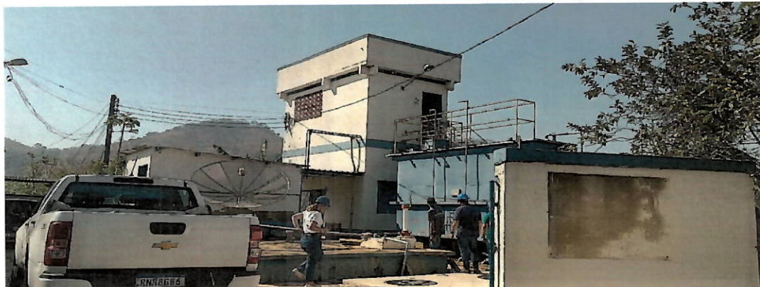
Figura 49 – Vista da entrada principal da Estação de Tratamento.
