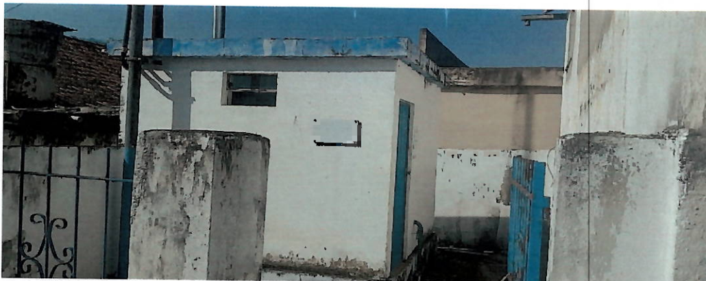
Figura 47 – Poço Venda das Flores - Vista externa.
