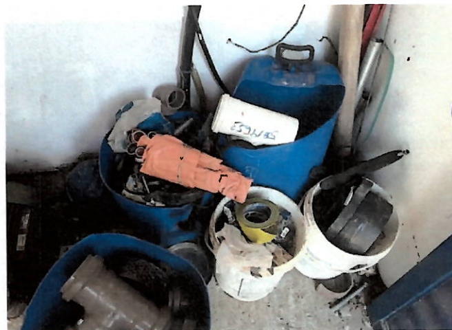
Figura 34 – Acondicionamento inadequado de materiais.
