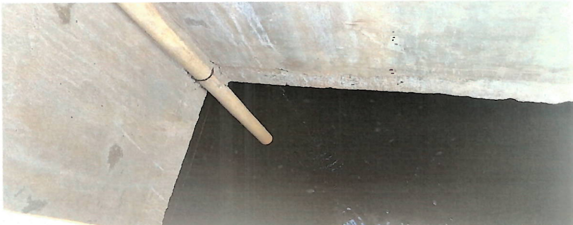
Foto 21 – Reservatório enterrado com capacidade de 240 m³.
