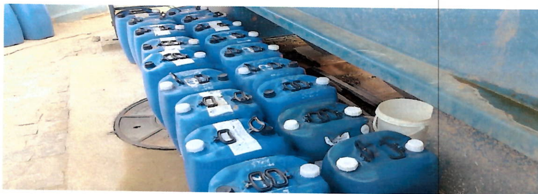
Figura 51 – Armazenamento de Sulfato de Alumínio.
