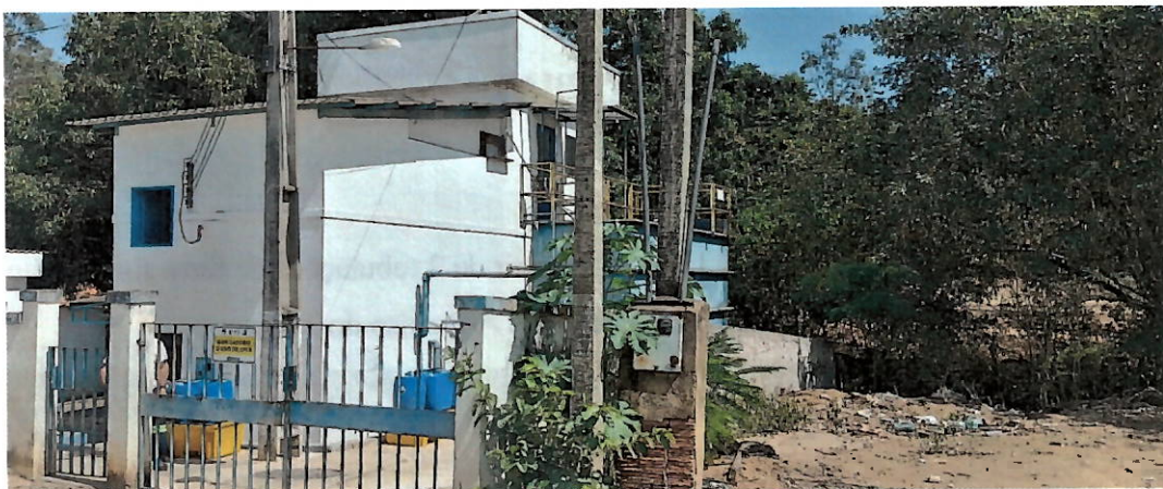
Figura 37 – Vista da entrada principal da Estação de Tratamento.
