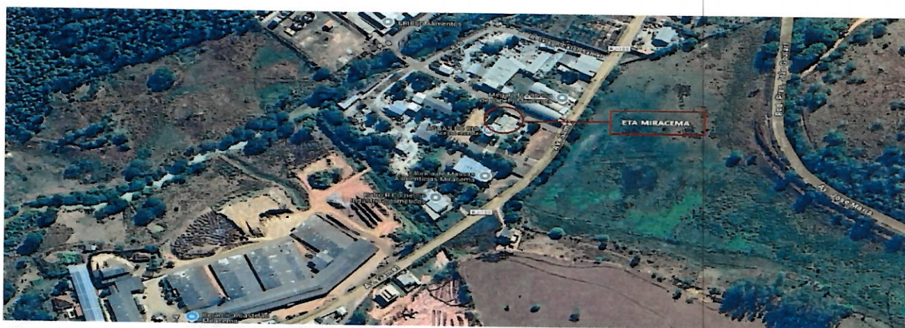
Imagem 01: localização da Estação de Tratamento Miracema.
