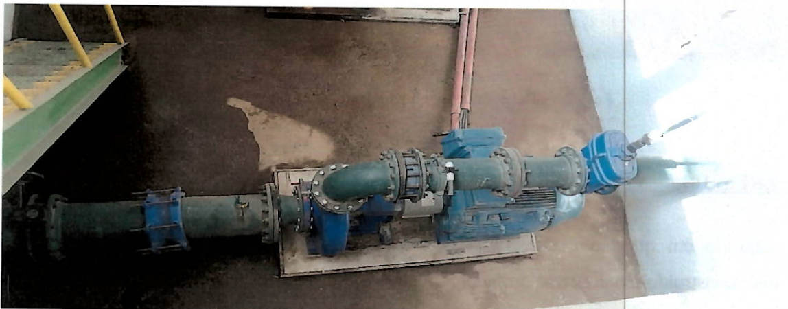
Figura 24 – Conjunto motobomba com potência de 150 cv.
