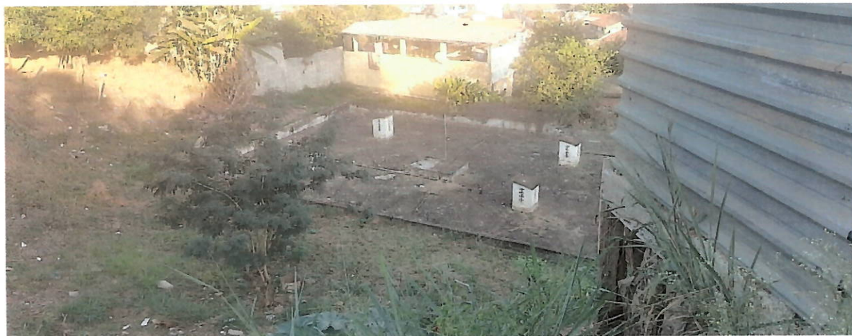
Foto 27 – Reservatório Semienterrado com capacidade: 500 m³.
