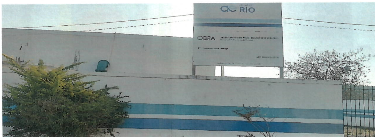
Foto 28 – Vista da entrada do Reservatório.
