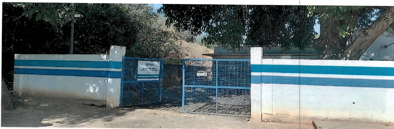
Foto 01 - Entrada da Estação Elevatória de Água Bruta e Captação.
