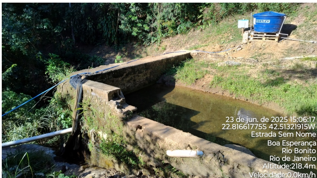
Foto 05 – Vista da barragem de captação.
