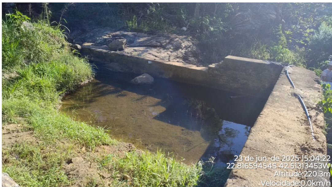
Foto 04 – Vista da barragem de captação.
