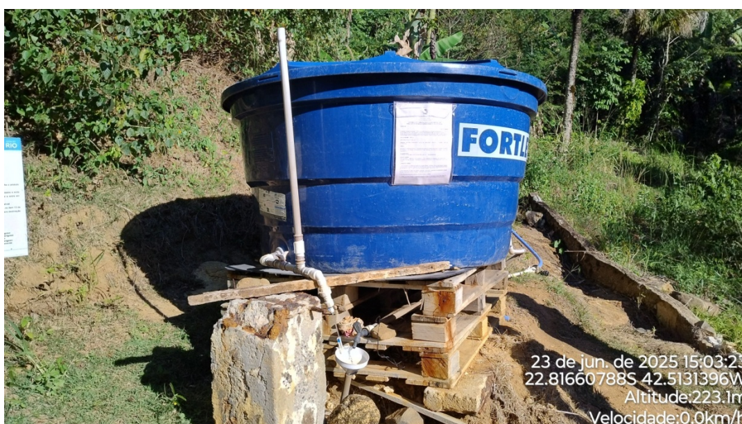
Foto 02 – Caixa de diluição do Hipoclorio de sódio e a identificação da licança ambiental.
