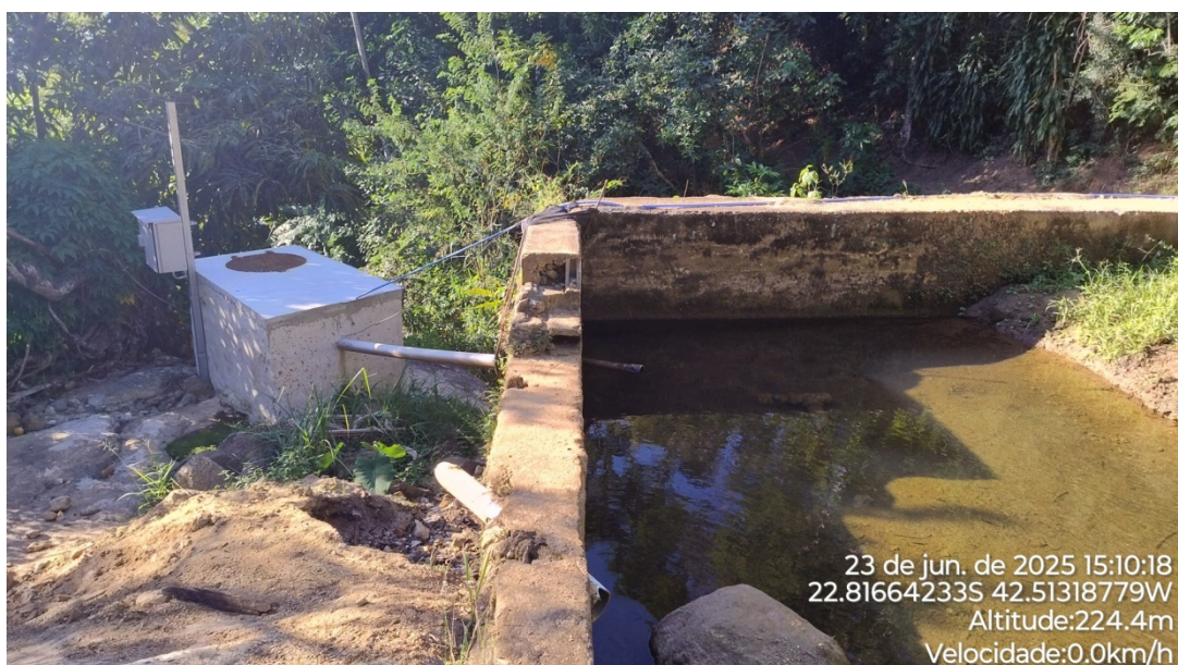
Foto 06 – Vista da barragem de captação.
