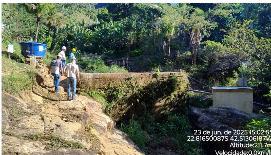
Foto 01 – Vista da barragem de captação.
