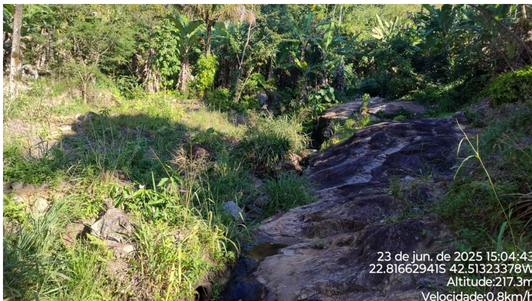
Foto 08 – Vista a montante da captação.
