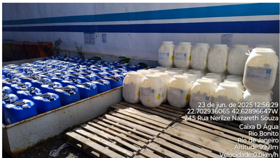
Foto 18 – Armazenagem de pastilhas de Hipoclorito de Cálcio e Ácido Fluossilícico
