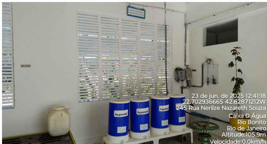
Foto 08 – Sistema de cloração auxiliar com pastilhas de hipoclorito de cálcio
