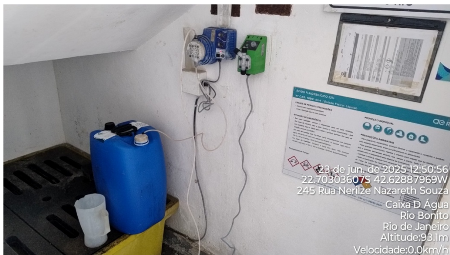
Foto 17- Dosador de ácido fluossilícico
