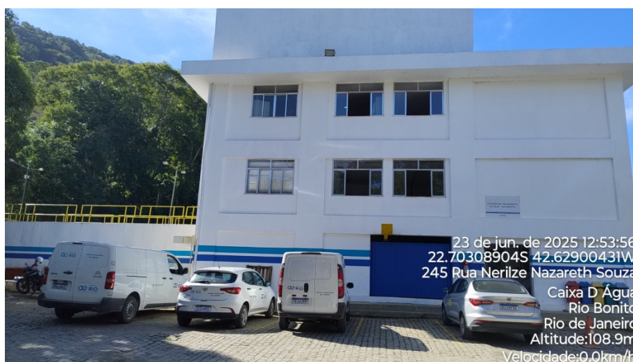
Foto 01- Vista parcial da ETA
