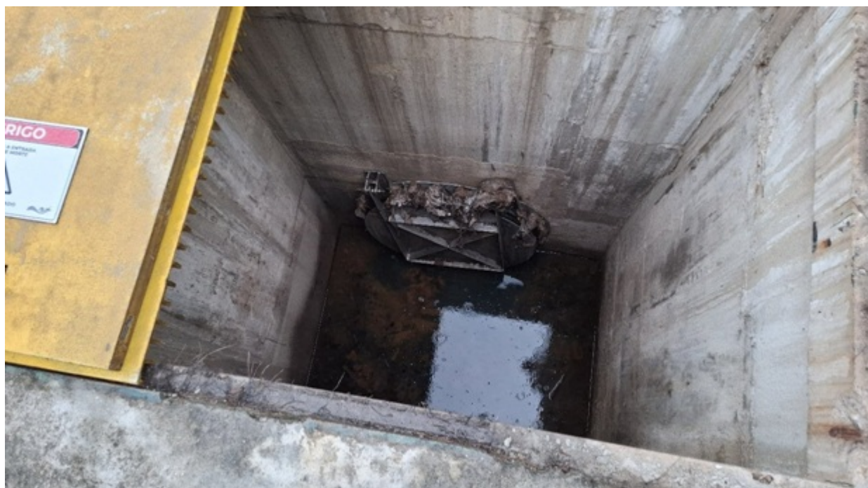
Foto 24 – Caixa extravasora com a válvula FLAP
