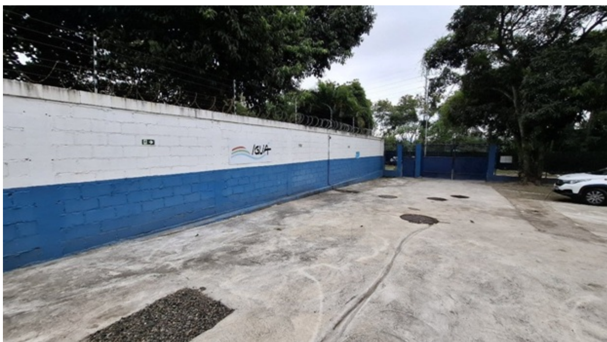
Foto 2 – Muro de alvenaria lateral
