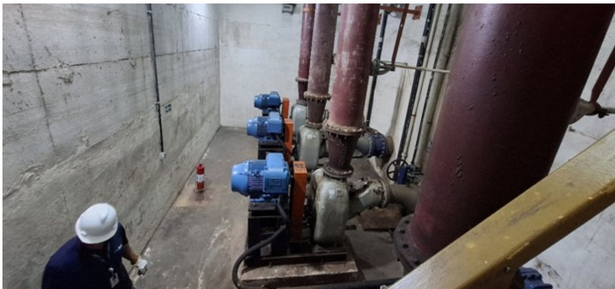
Foto 17 – Poço das motobombas
