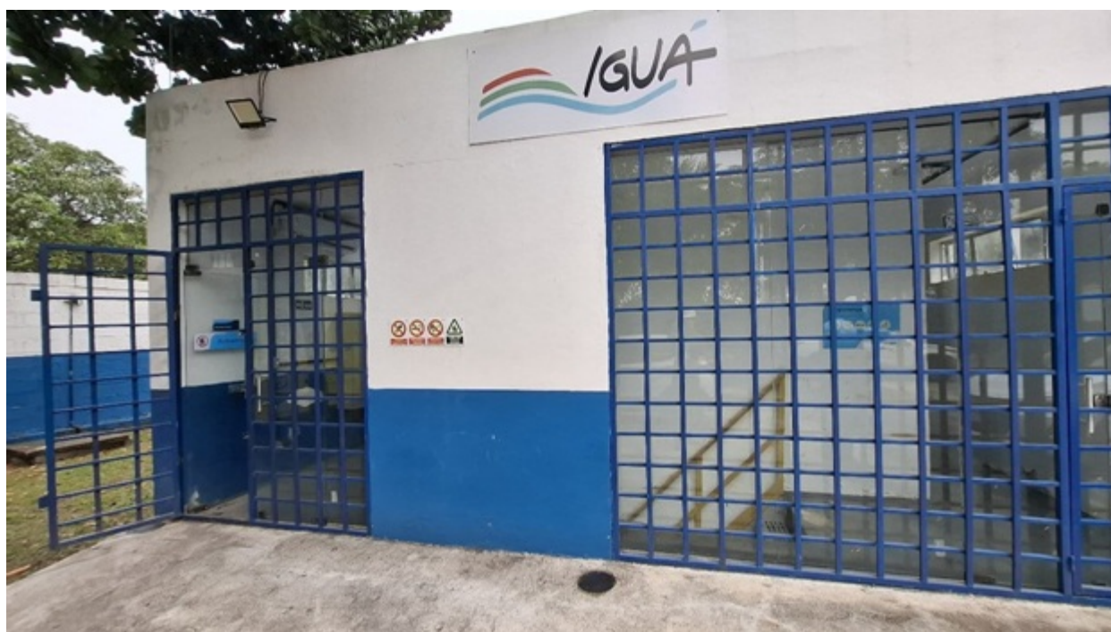
Foto 10 – Fachada frontal da entrada do abrigo dos painéis de controle da elevatória e das motobombas
