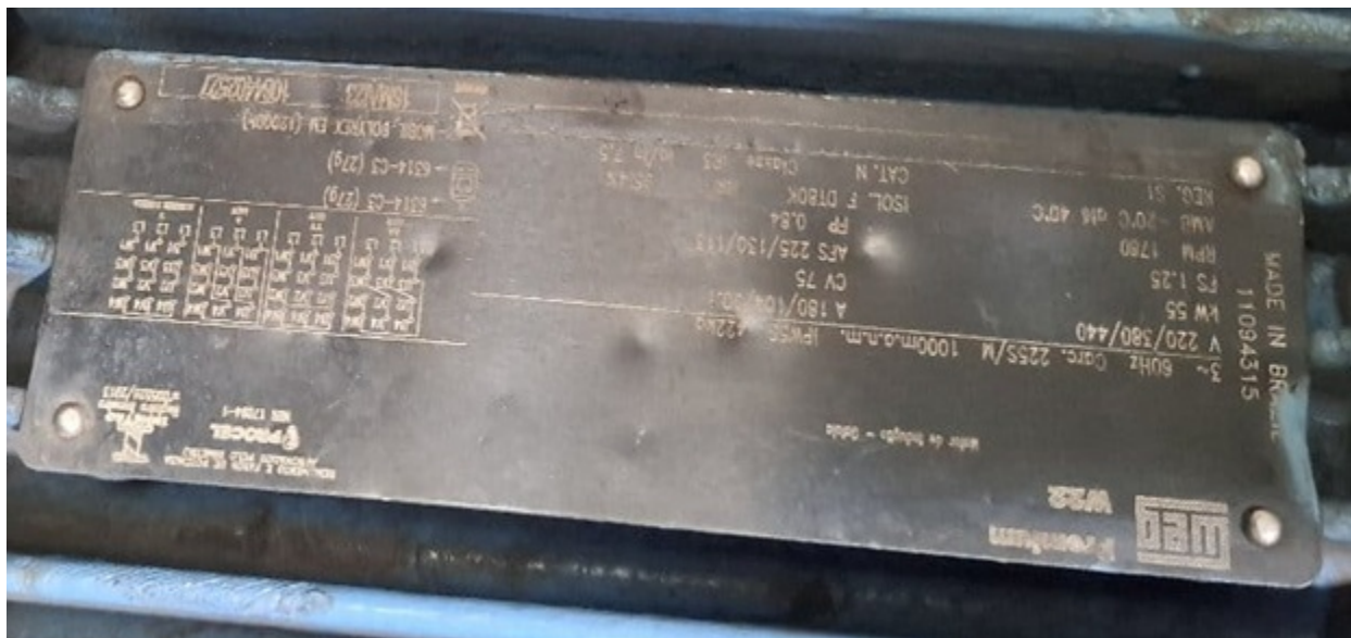
Foto 18 – Placa de especificação da motobombas
