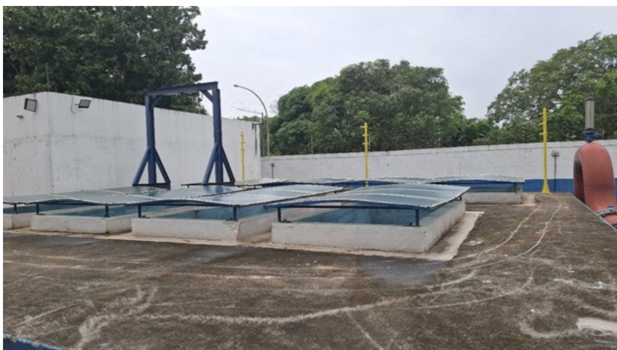
Foto 12 – Iluminação natural do abrigo das motobombas proveniente de telhas incolores
