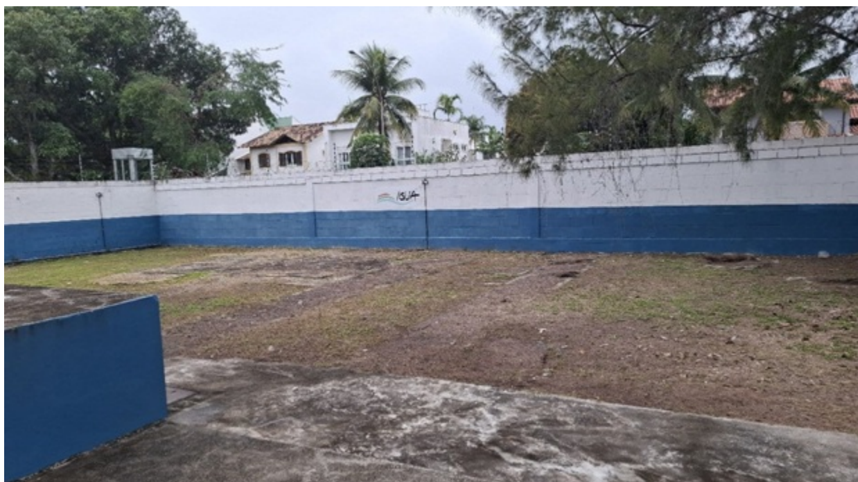
Foto 3 – Muro de alvenaria nos fundos
