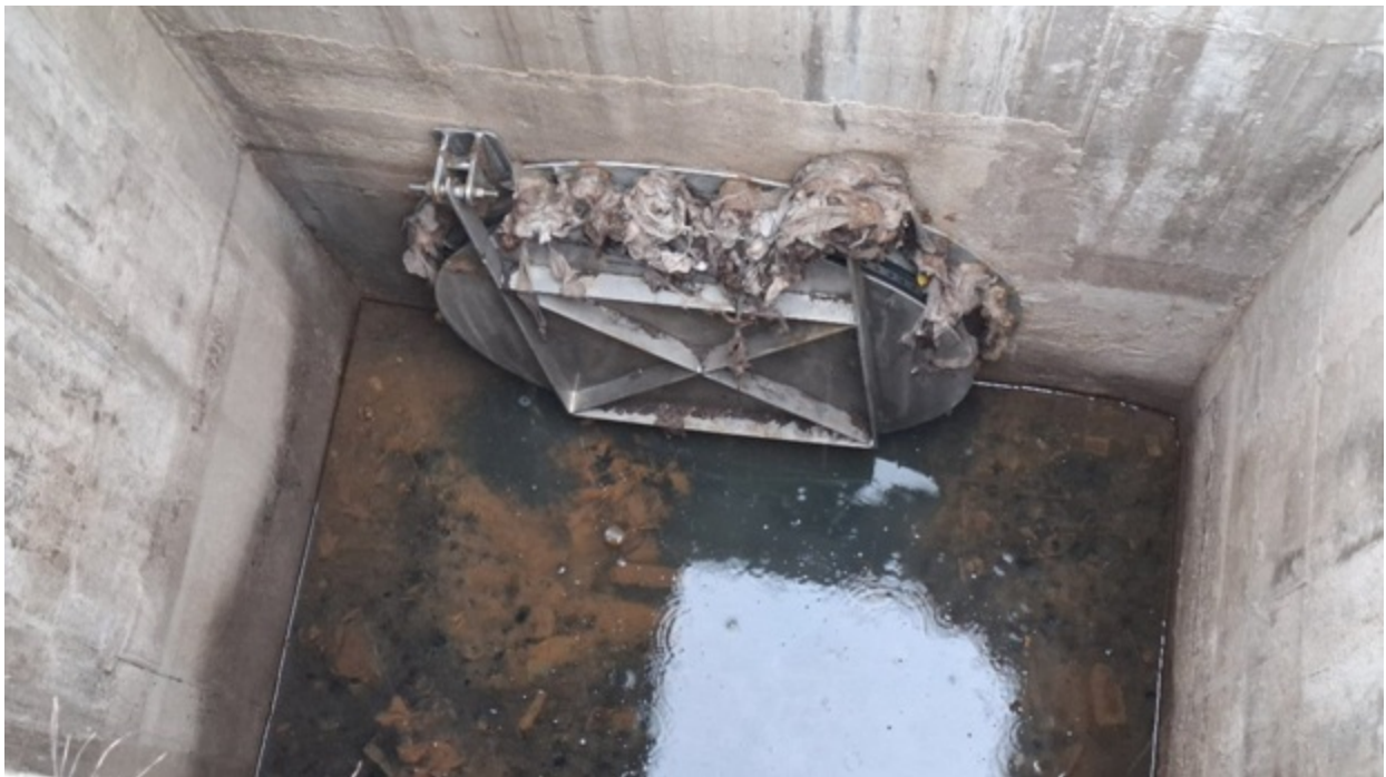
Foto 25 – Caixa extravasora com a válvula FLAP
