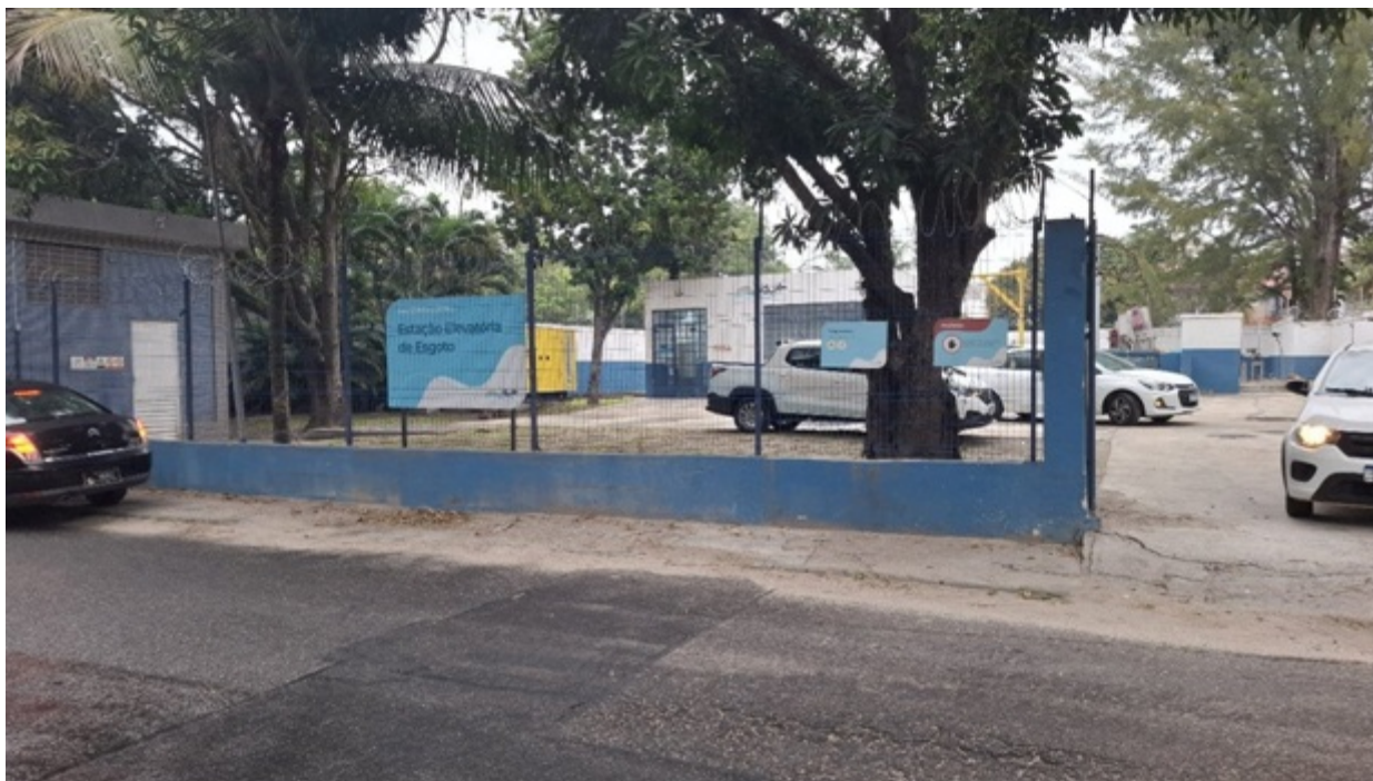
Foto 1 – Vista frontal com identificação da EEBB
