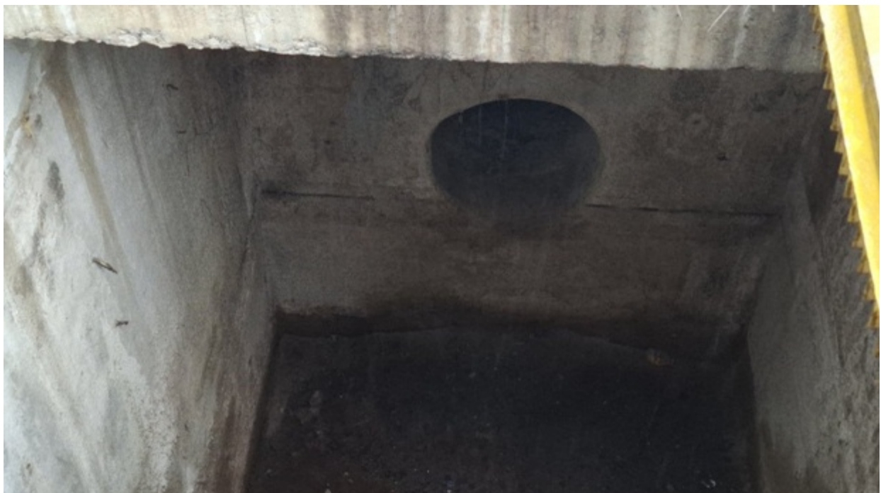
Foto 26 – Caixa extravasora com saída para o local do extravasamento
