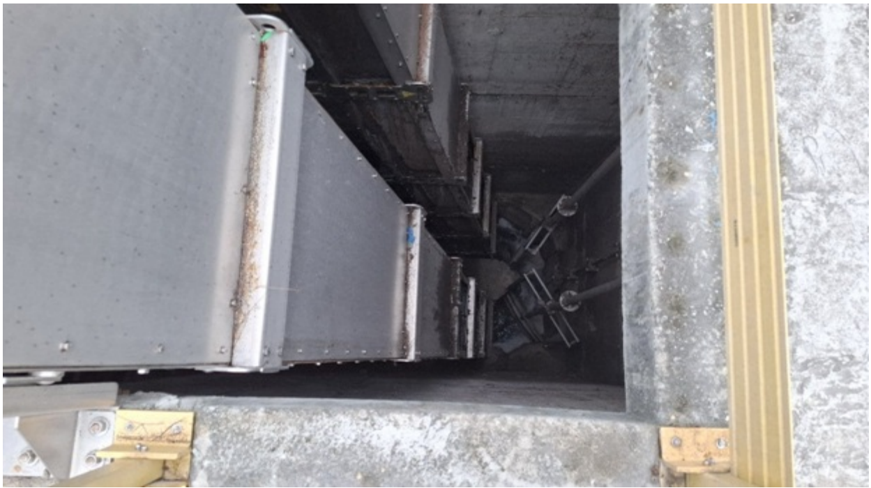
Foto 5 – Gradeamentos mecânicos
