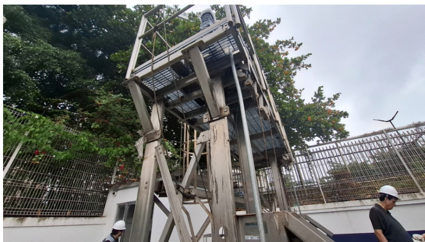
Foto 2 – Grade e muro de alvenaria
