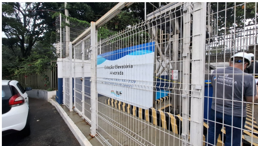
Foto 1 – Identificação e grade de proteção da EEEB
