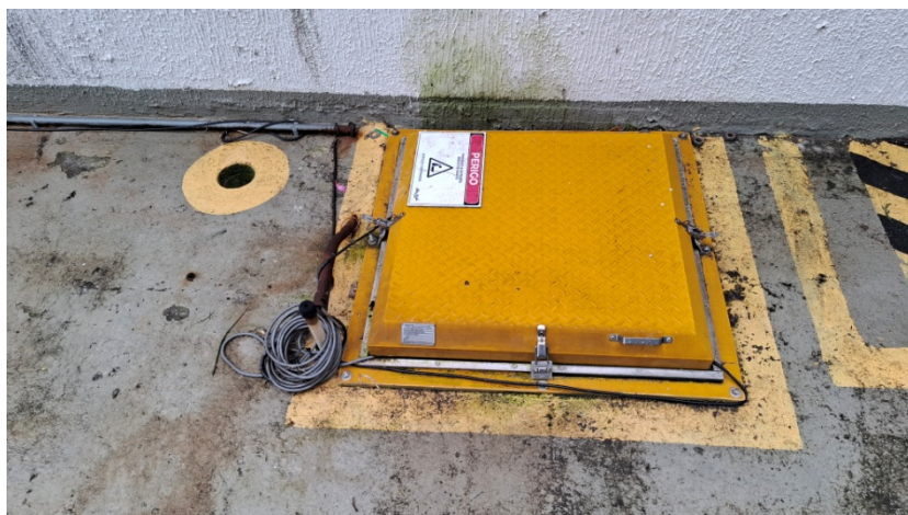
Foto 12 – Tampa do poço de sucção
