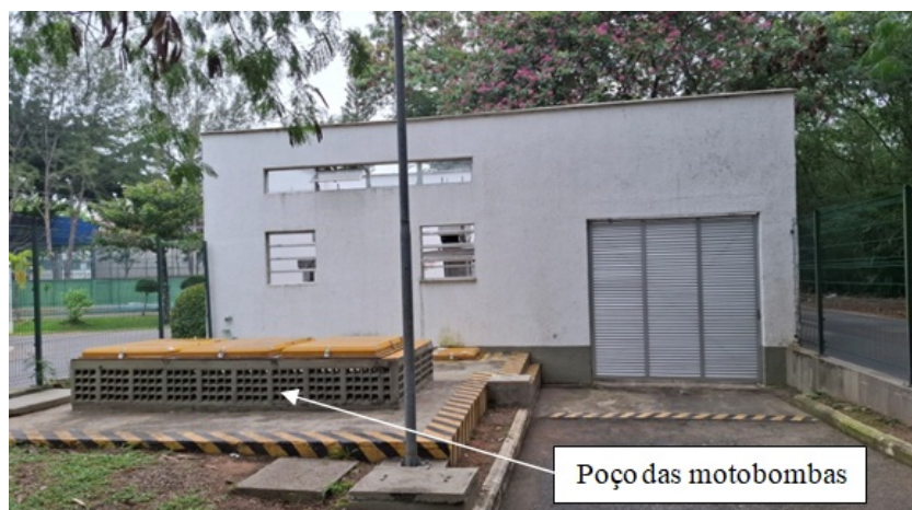
Foto 14 – Poço das motobombas
