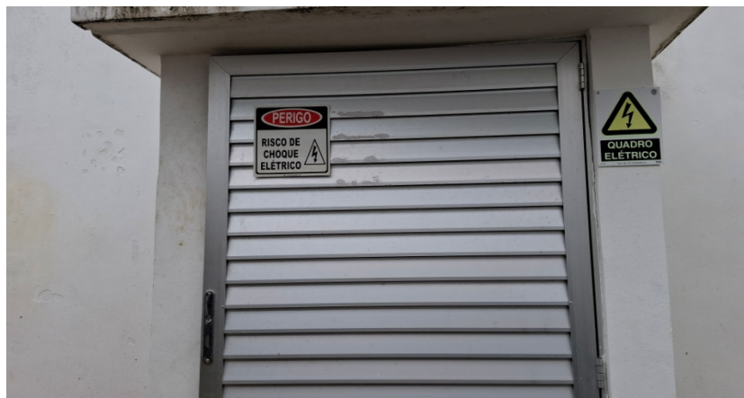
Foto 10 – Abrigo de alvenaria do painel elétrico do gradeamento
