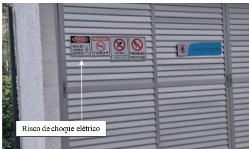
Foto 4 – Sinalizações de advertência
