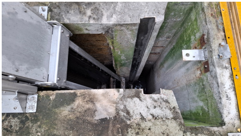
Foto 8 – Gradeamento mecânico
