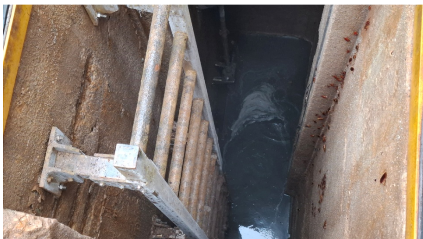
Foto 6 – Interior da caixa receptora
