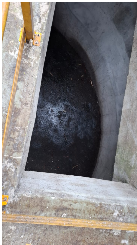
Foto 9 – Caixa receptora com guarda corpo
