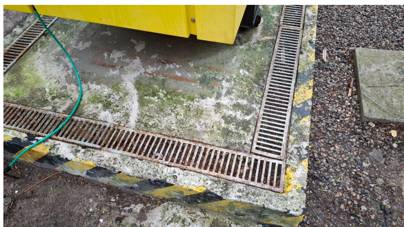
Foto 8 – Bacia de contenção
