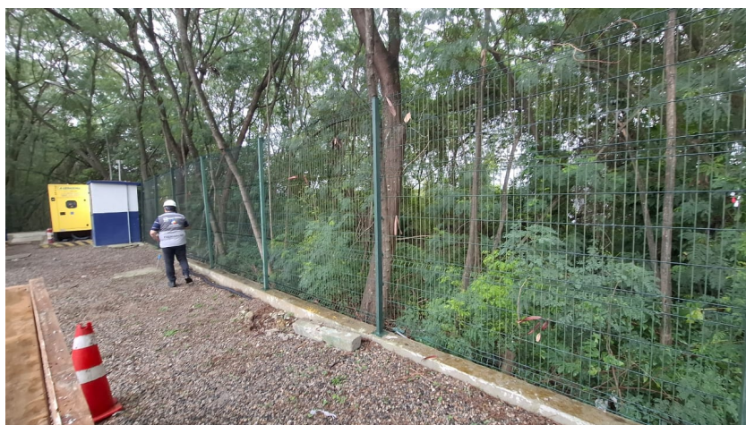
Foto 2 – Grade que protege toda área da EEEB
