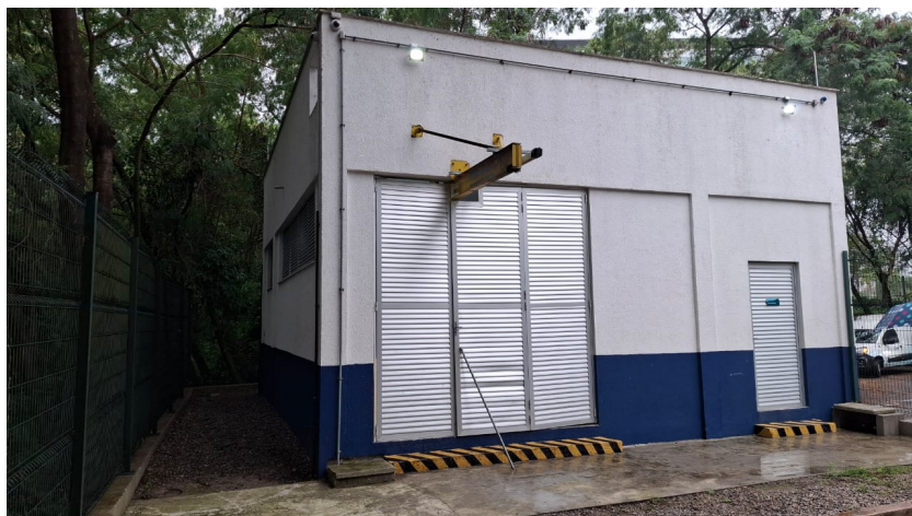
Foto 4 – Abrigo dos painéis de controle da elevatória e das motobombas
