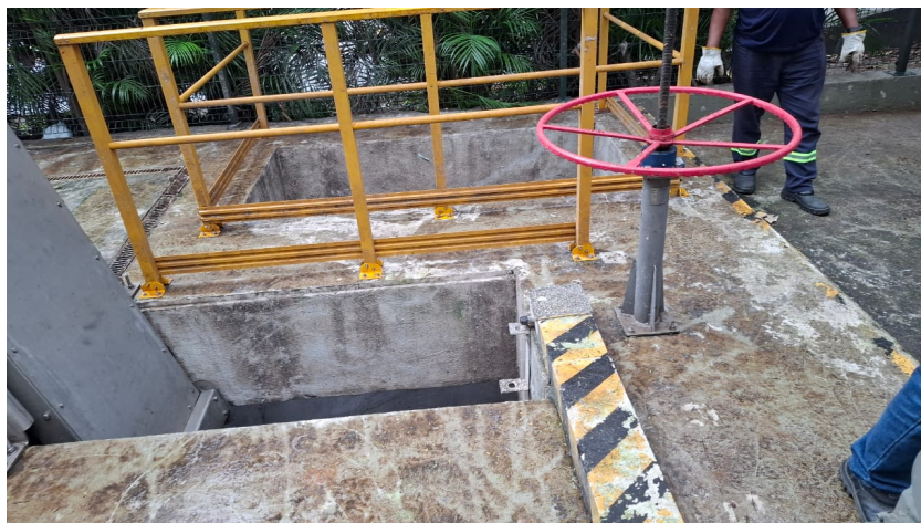
Foto 10 – Caixa receptora com parte do guarda corpo
