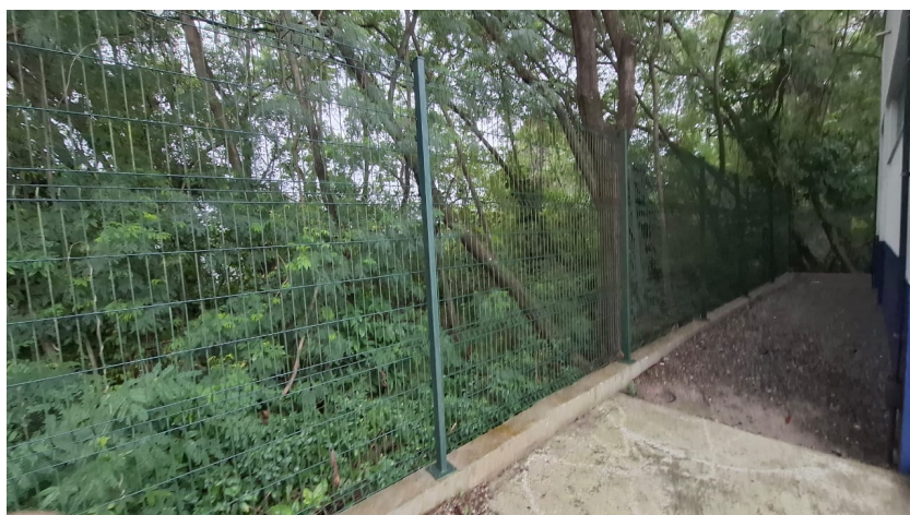
Foto 3 – Grade que protege toda área da EEEB
