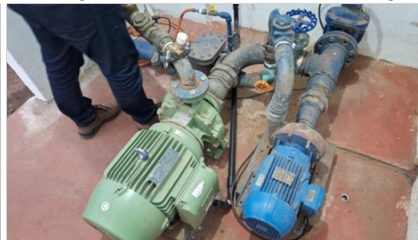
Foto 15, 16, 17, 18 – Fotos da EEAT de Porto das Barcas, que opera com dois grupos moto-bomba em áreas de influência distintas, assim não possuem grupo reserva para situações de pane. Este sistema recalava de uma pressão de 0,15 mca de retaguarda para 60 mca em tubulação de 75 mm , caracterizando que o sistema recuperou a pressão para transporte de água, mas transporta pouca vazão.
