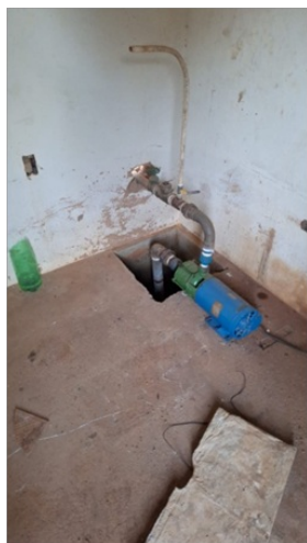
Fotos 13 E 14 - O sistema de bombeamento de Funil foi reformado com a troca do conjunto moto-bomba e troca do quadro de comando, colocação de inversor de frequência, ficando pendentes a reforma do prédio.
