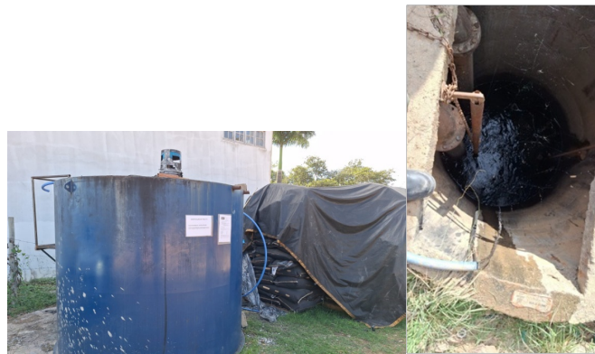
Fotos 3 e 4 – Dosagem de carvão ativado no tanque e adição de solução na Elevatória de água bruta.
