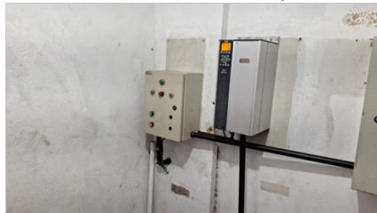
Foto 15, 16, 17, 18 – Fotos da EEAT de Porto das Barcas, que opera com dois grupos moto-bomba em áreas de influência distintas, assim não possuem grupo reserva para situações de pane. Este sistema recalava de uma pressão de 0,15 mca de retaguarda para 60 mca em tubulação de 75 mm , caracterizando que o sistema recuperou a pressão para transporte de água, mas transporta pouca vazão.
