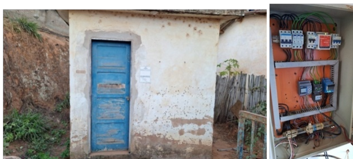
Fotos 11, 12: O sistema de bombeamento de Funil foi reformado com a troca do conjunto moto-bomba e troca do quadro de comando, colocação de inversor de frequência, ficando pendentes a reforma do prédio.
