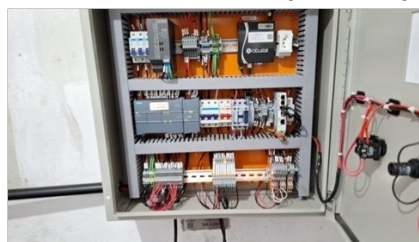
Foto 15, 16, 17, 18 – Fotos da EEAT de Porto das Barcas, que opera com dois grupos moto-bomba em áreas de influência distintas, assim não possuem grupo reserva para situações de pane. Este sistema recalava de uma pressão de 0,15 mca de retaguarda para 60 mca em tubulação de 75 mm , caracterizando que o sistema recuperou a pressão para transporte de água, mas transporta pouca vazão.
