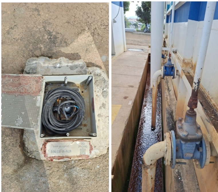
Fotos 5 e 6 – Sensor eletrônico de nível do reservatório de água tratada, e válvulas de descarga do filtro trocadas.
