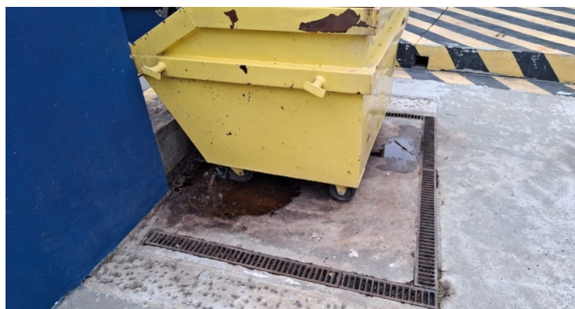
Foto 16 – Bacia de contenção
