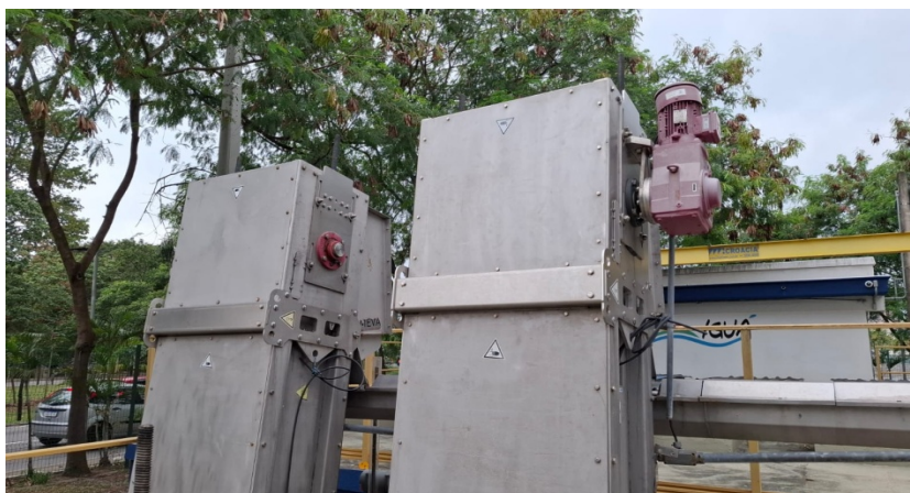
Foto 10 – Gradeamento mecânico
