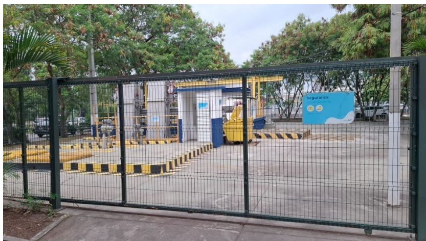
Foto 2 – Grade que protege toda área da EEEB
