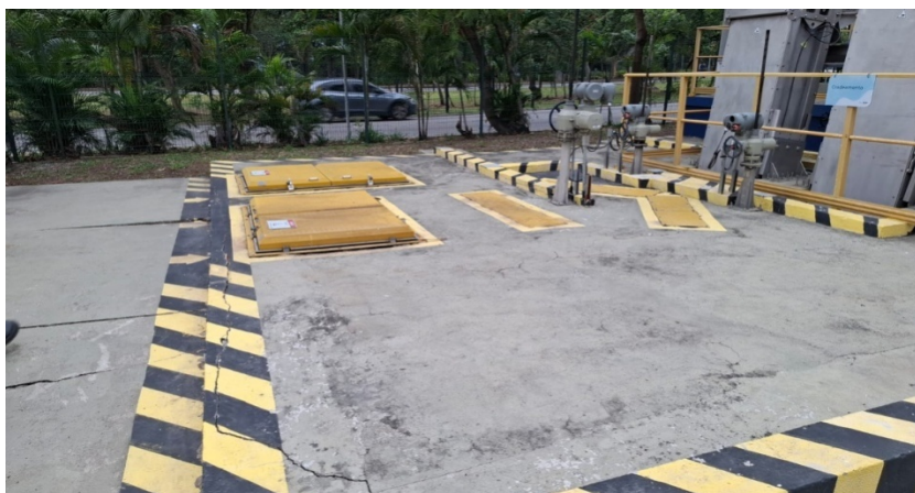
Foto 8 – Tampas da caixa receptora
