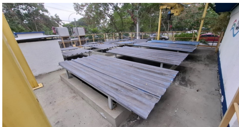
Foto 17 – Telhas cobrindo as aberturas
