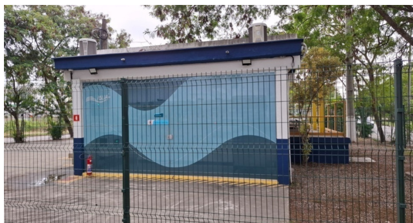
Foto 3 – Abrigo dos painéis de controle da elevatória
