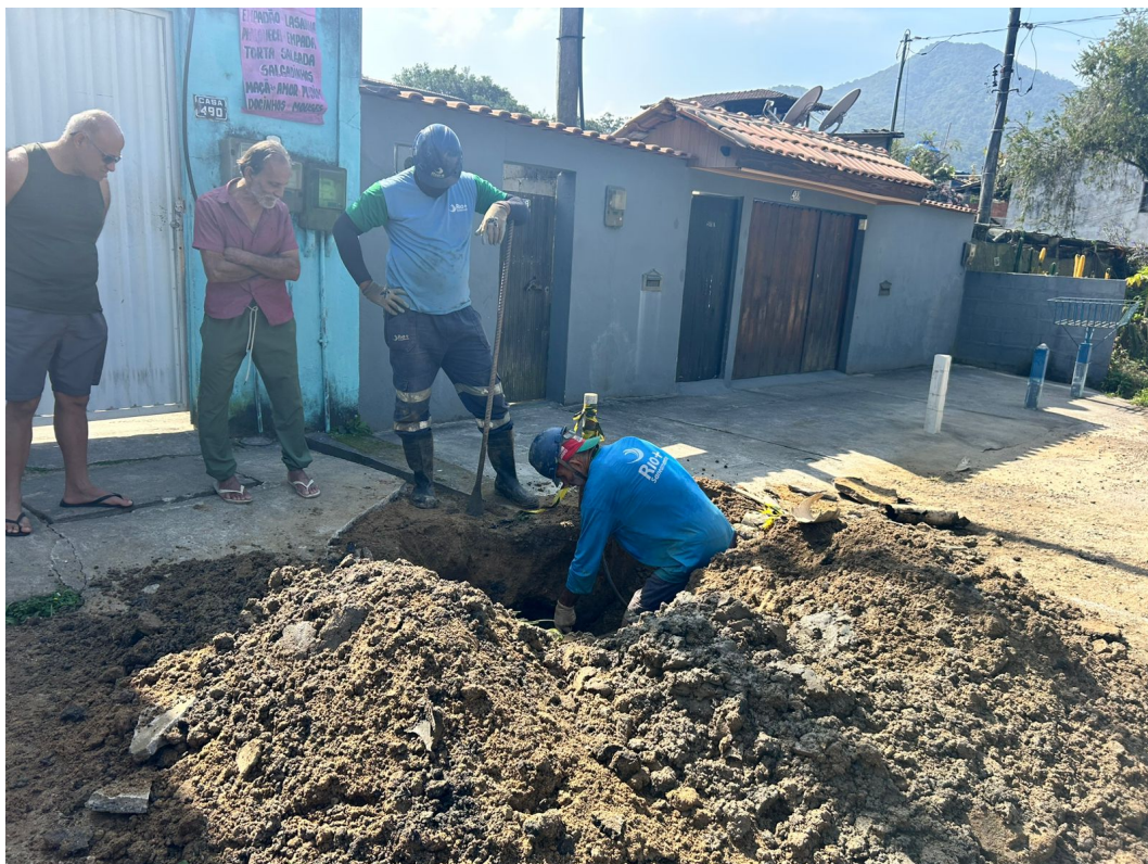
Foto 02 – Sondagem sendo realizada no logradouro Caminho da Ilha
