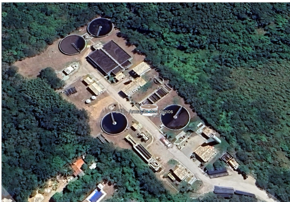
Foto 2 – Vista superior da ETE
