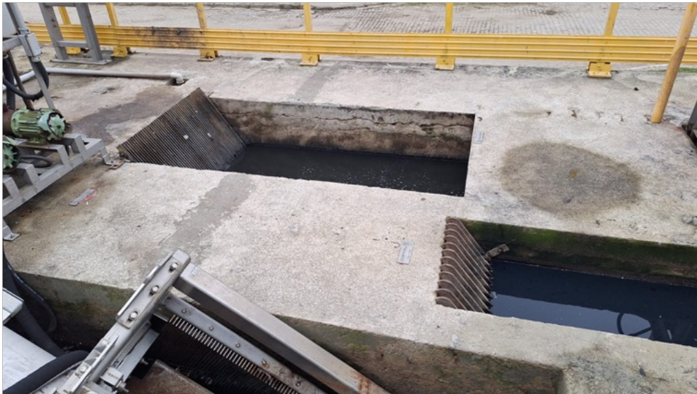
Foto 4 – Gradeamento grosso ( limpeza manual )
