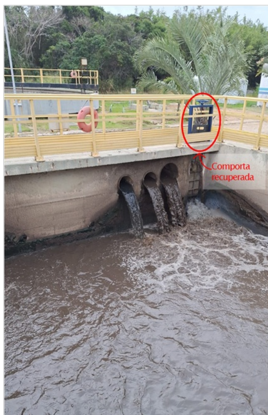
Foto 10 – Tanque Anóxico, que recebe efluente do Decantador Primário e da Recirculação do Secundário. .
