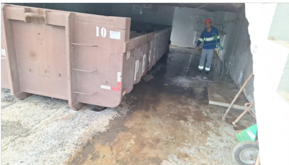
Foto 21 – Caçamba para armazenamento e transporte para aterro do lodo desidratado.
