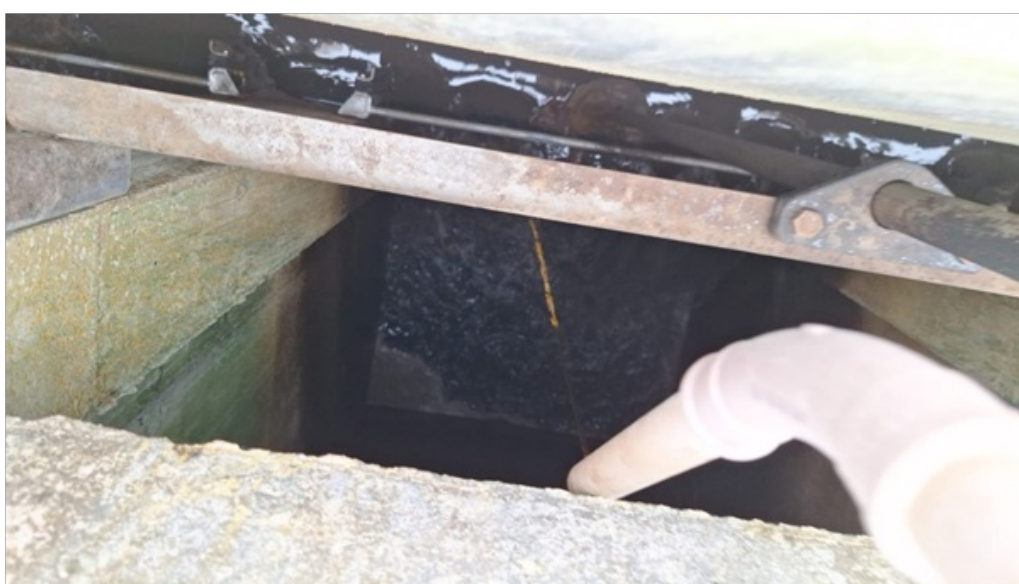
Foto 16 – Dosagem de PAC na saída do tanque de aeração.
