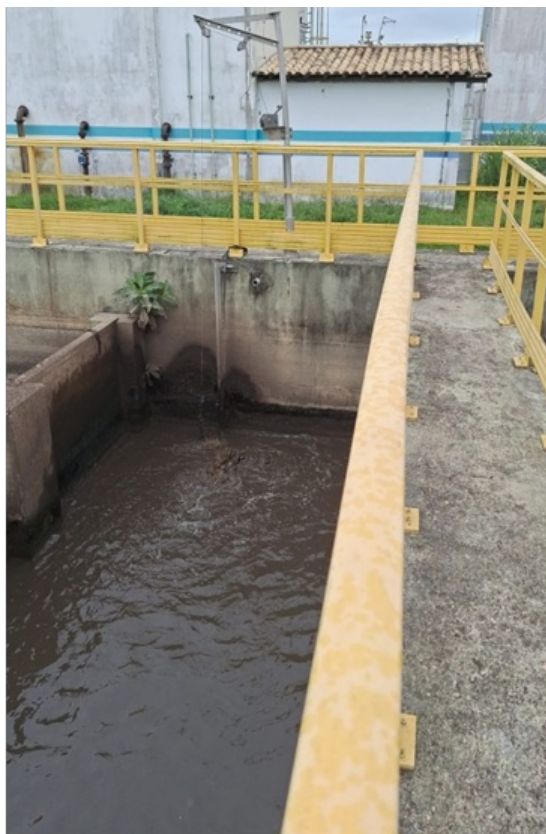
Foto 11 – Mixer para agitação das áreas com pouco fluxo (zonas mortas) .
