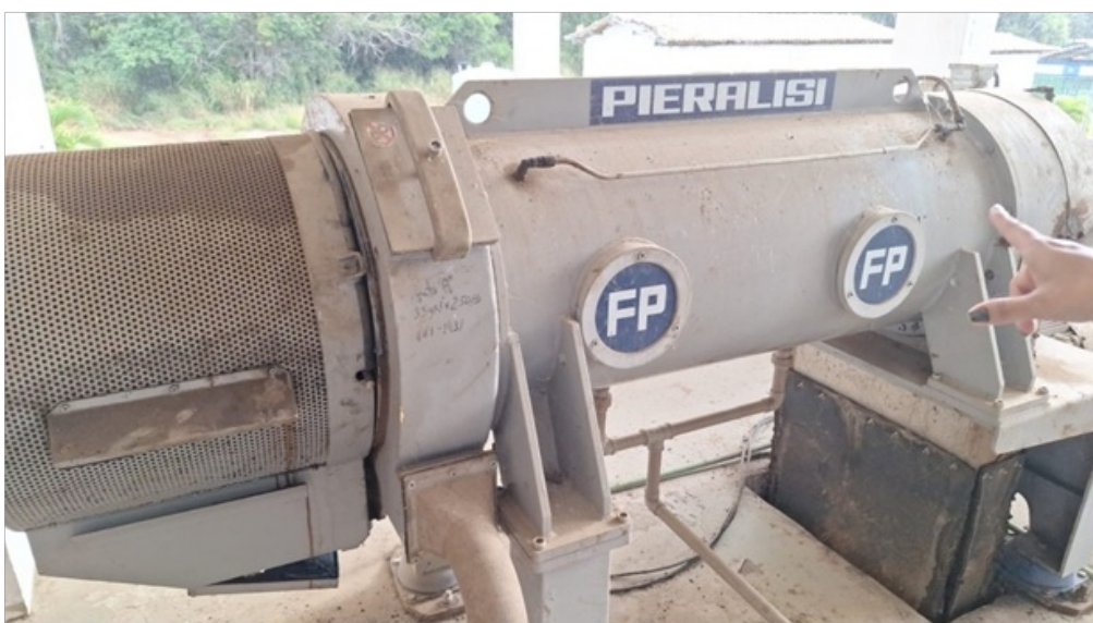
Fotos 19 e 20 - Reservatório de polímero e centrífuga para coagulação e desidratação do lodo do Dec. Secundário.
