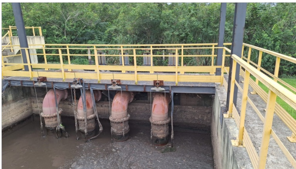
Foto 12 – Elevatória de esgoto decantado.
