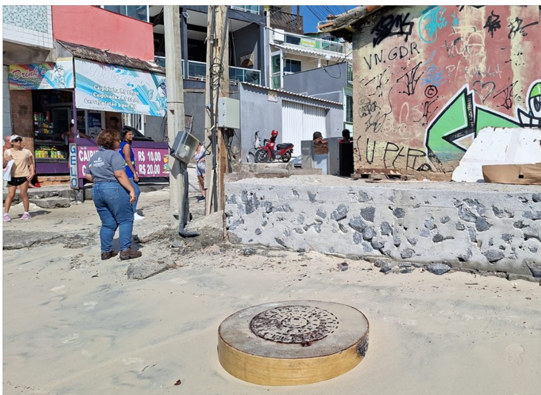
Foto 3 – Quadro elétrico, tampa do PV que deságua no poço da EEE que está sobre o dique.
