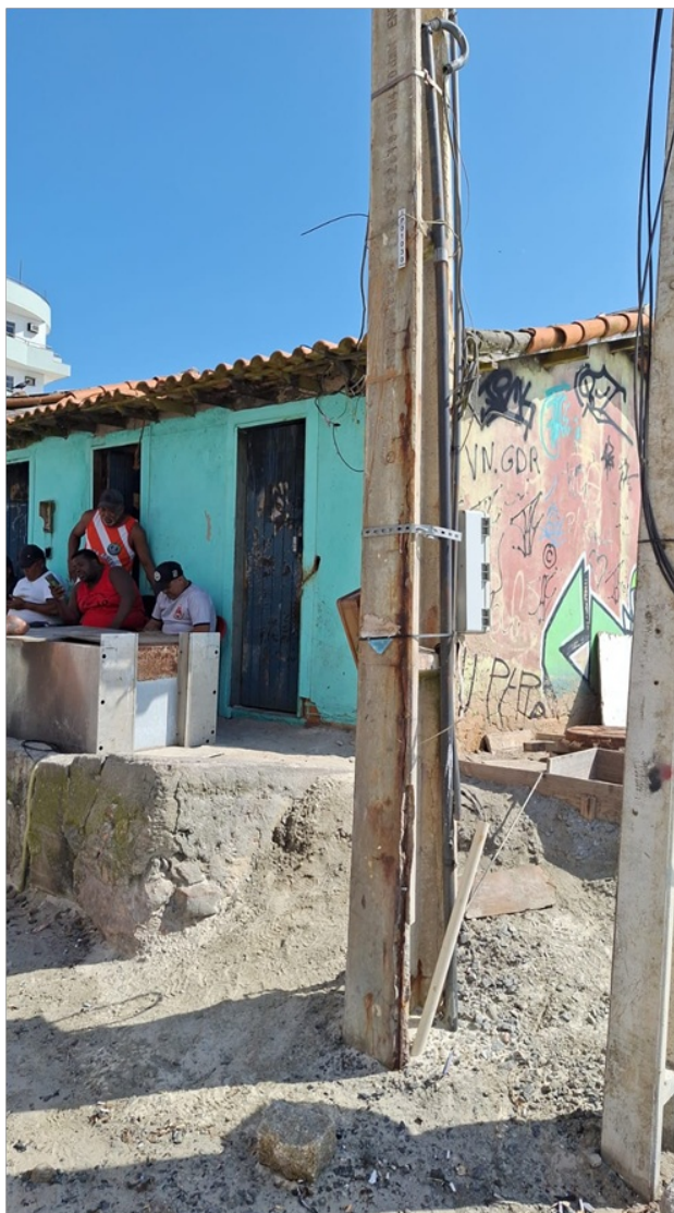
Foto 2 – Vista do local da EEE/ barraca dos pescadores, onde há uma pendenga com a Concessionária por uma compensação pela instalação da EEE, e assim não permitem melhorias até que cheguem a um acordo.
