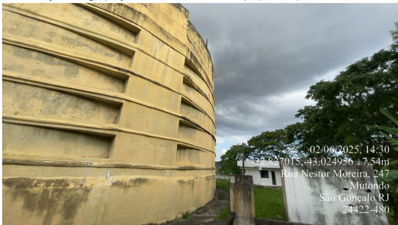
Foto 4 – Vista lateral do reservatório
