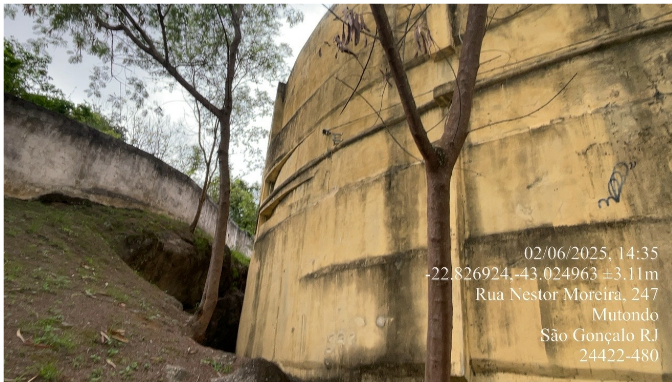
Foto 2 – Vista lateral do reservatório
