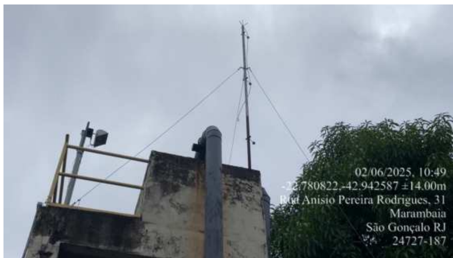
Foto 17-SPDA (Sistema de proteção contra descargas atmosféricas)
