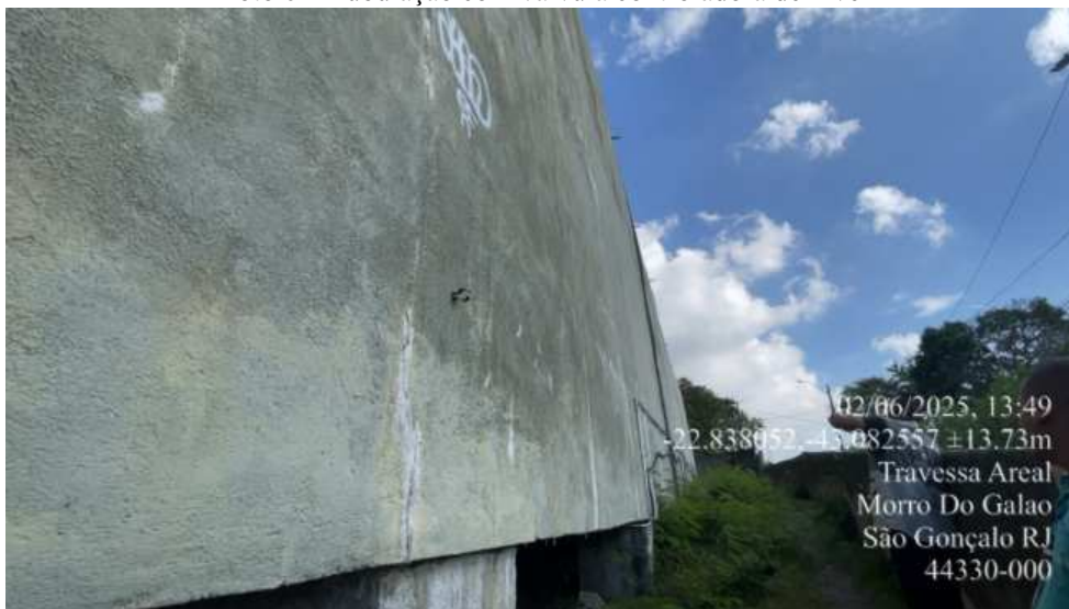
Foto 7 – Vista lateral do reservatório
