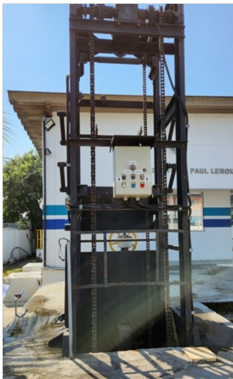
Foto 3 – Gradeamento mecanizado
