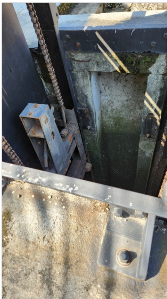
Foto 4 – Poço do gradeamento
