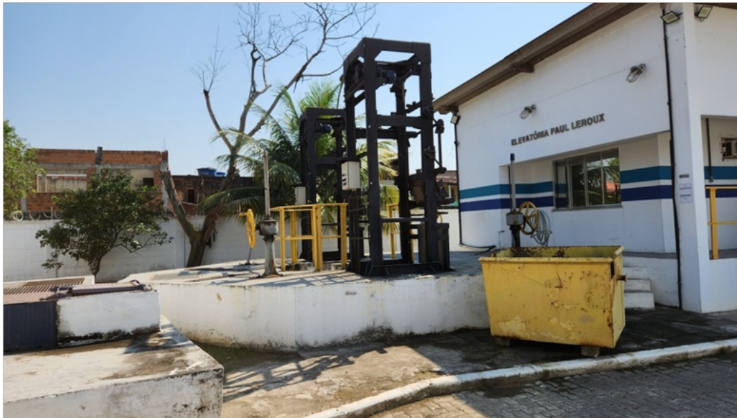
Foto 1 – Fachada elevatória e área de chegada do efluentes
