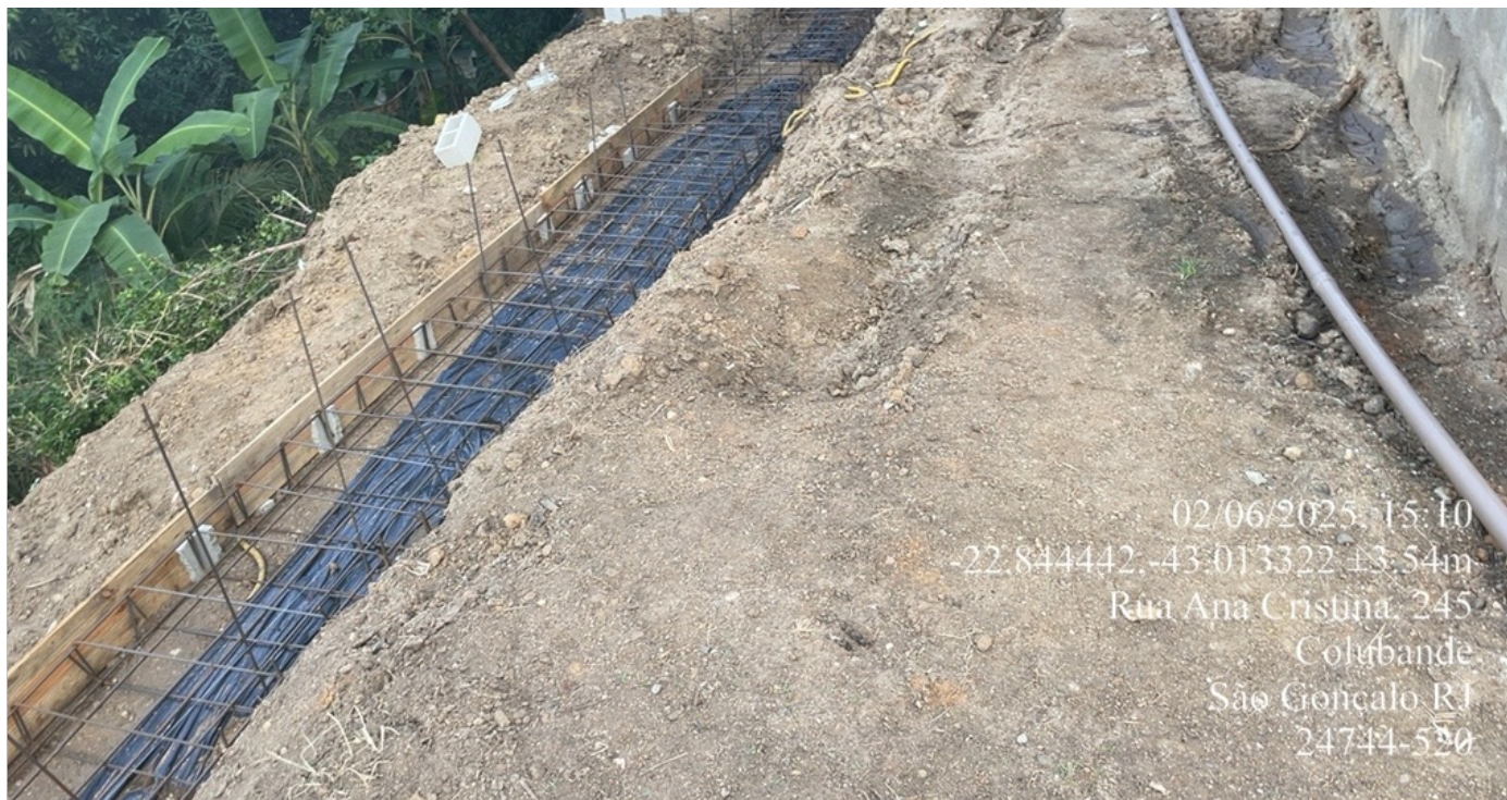
Foto 5 – Obra de muro de contenção de encosta
