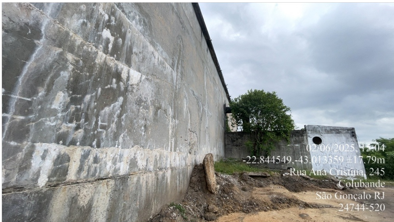
Foto 2 – Vista lateral do reservatório
