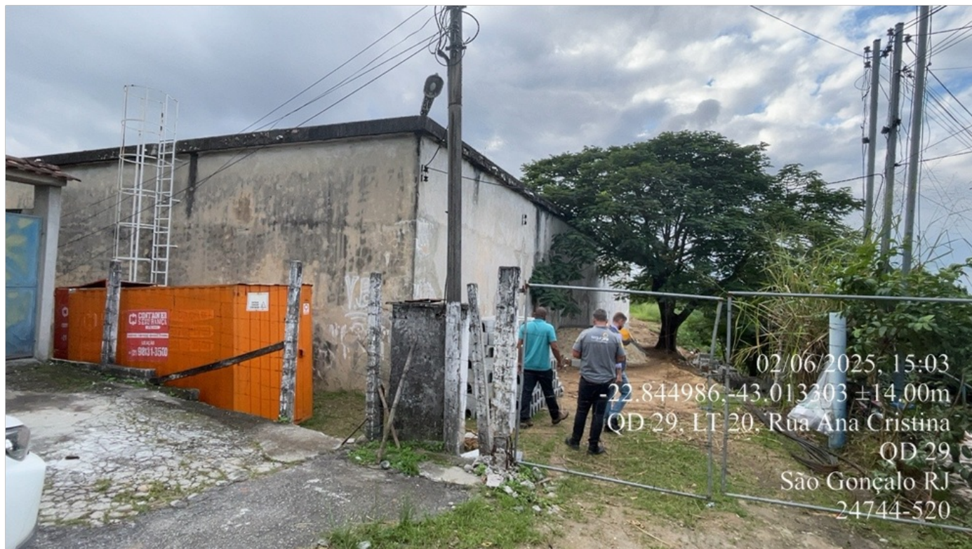
Foto 1 – Vista da entrada da ERES
