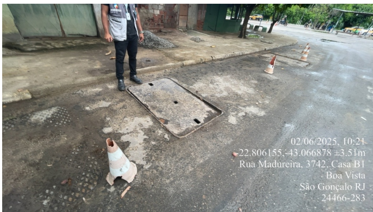
Foto 2 –Visitas do poço de sucção
