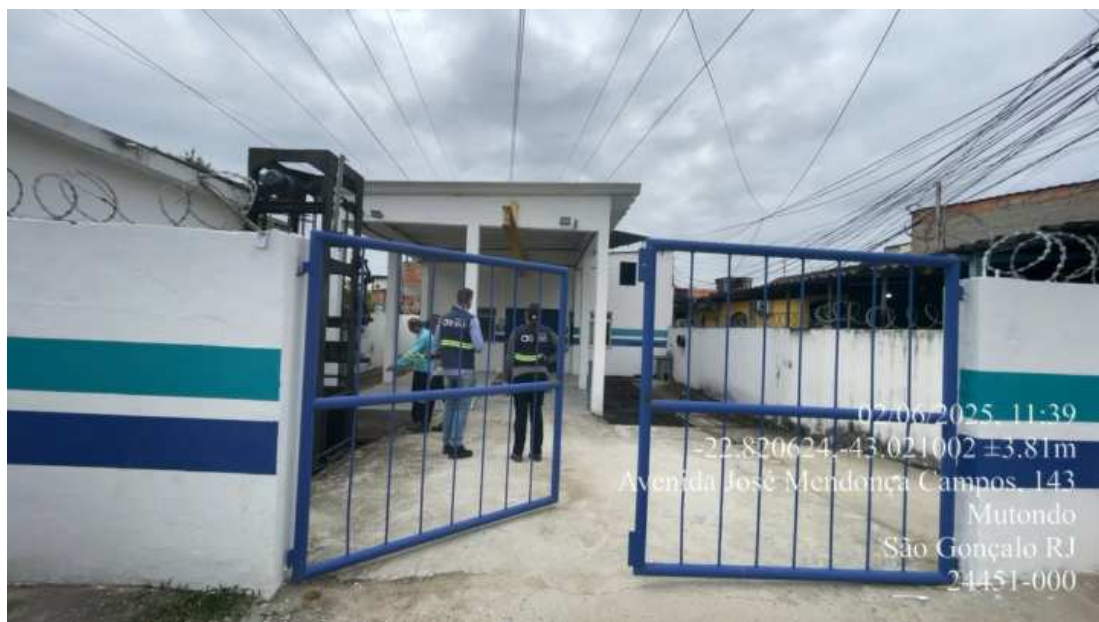
Foto 1 – Vista da fachada da EEE
