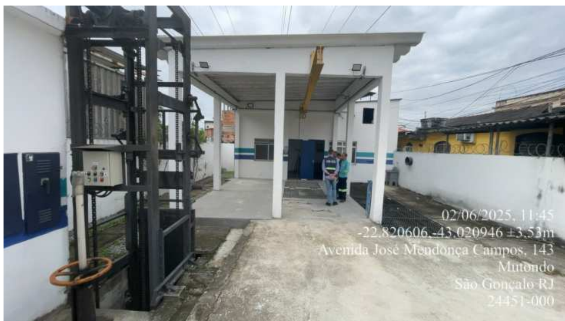
Foto 9 – Vista geral da unidade
