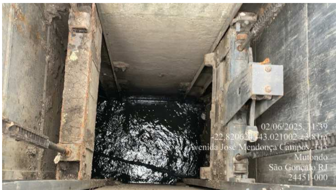
Foto 4 – Poço do gradeamento
