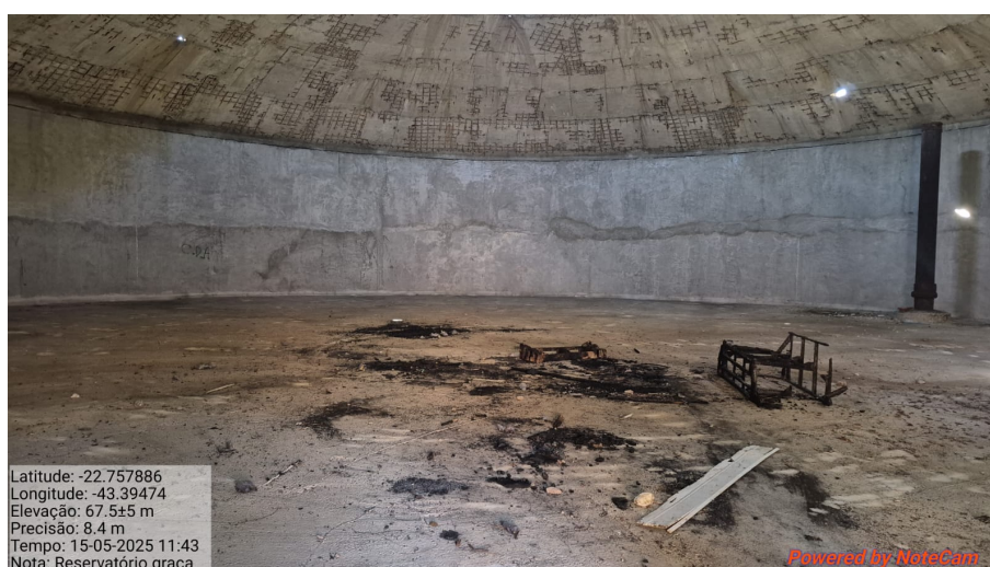
Foto 3: Reservatório vista interna
