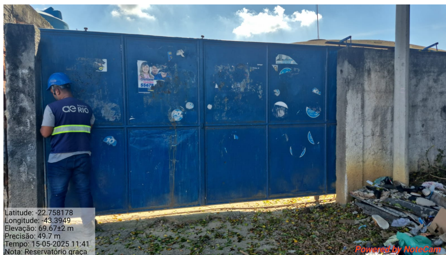
Foto 1: Porta de acesso a área do reservatório
