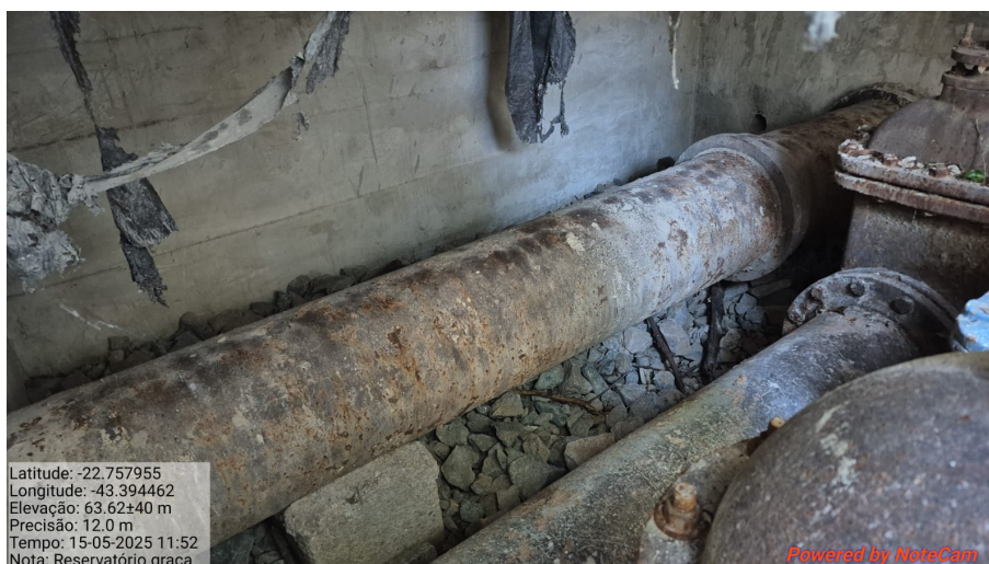
Foto 6: Barrilete de chegada
