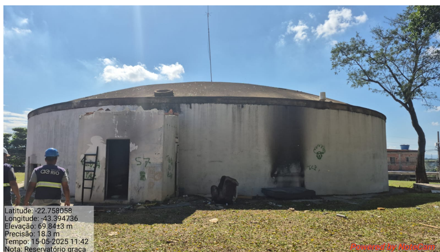
Foto 2: Reservatório vista externa
