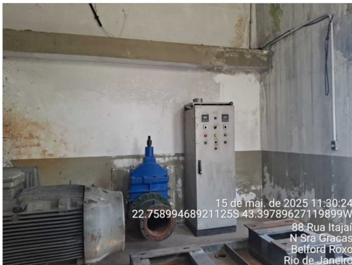
Foto 5 – Base para instalação conjunto motobomba
