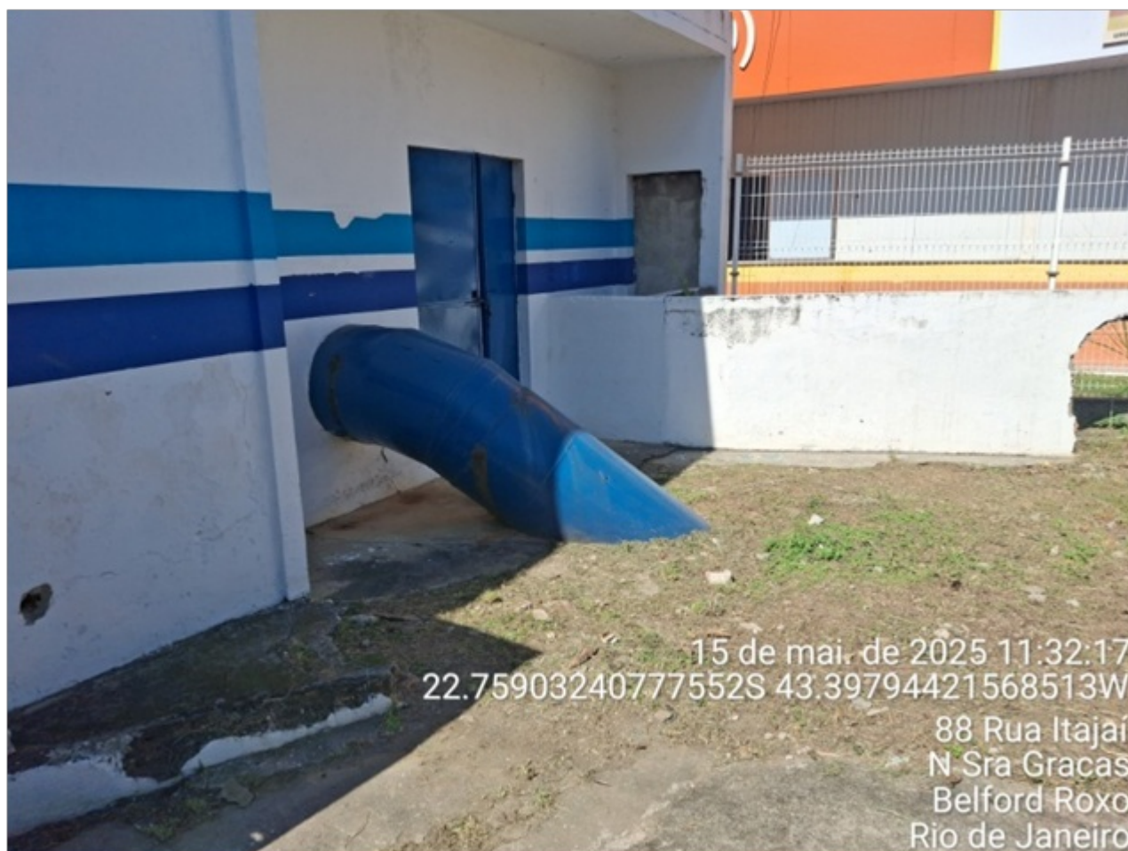
Foto 3 – Parte barrilete de sucção
