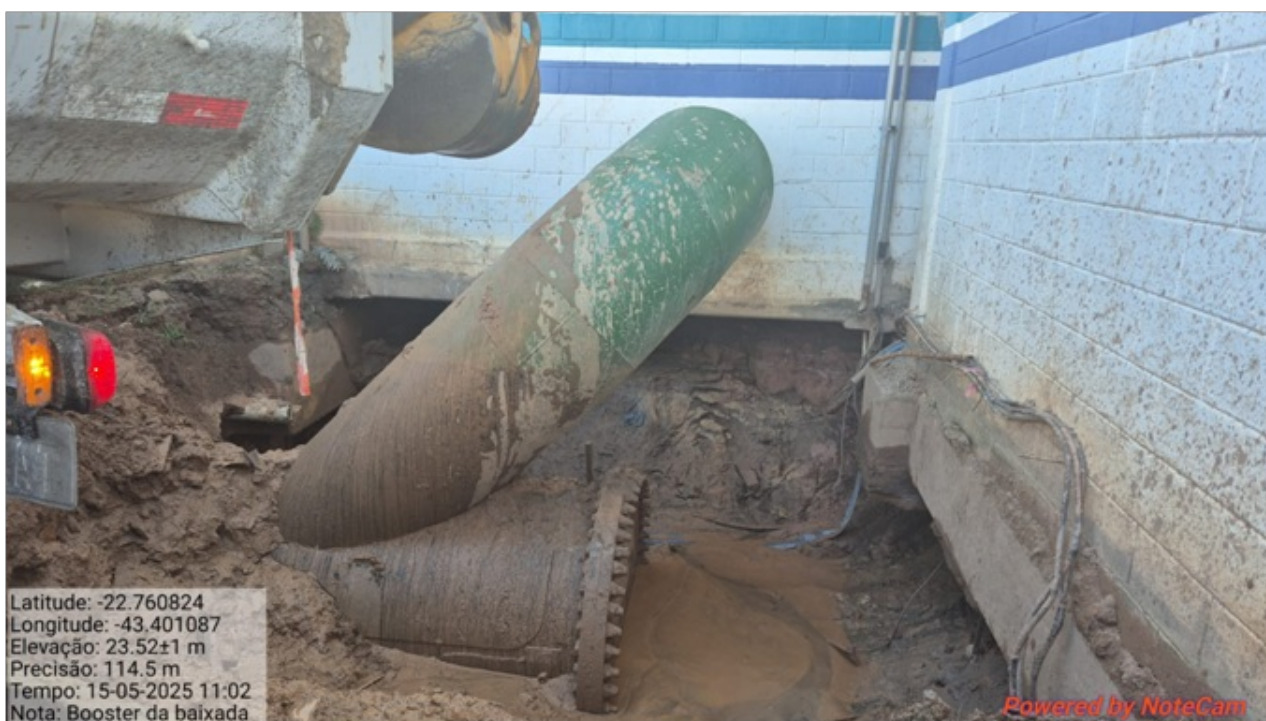
Foto 3 – Parte barrilete de sucção preparado para reparo
