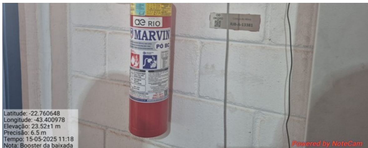
Foto 13 – Extintor de incêndio dentro da validade
