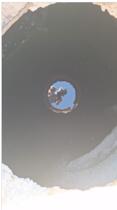
Fotos 5 – PV do inteceptor da Av. da Liberdade x Rua Roberto Siveira
