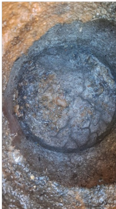
Foto 9 – PV do interceptor da Av. da Liberdade esquina com Rua Rui Barbosa
