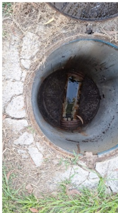
Foto 15 e 16 – PV's do coletor da Rua José Pinto de Macedo que tem destino na EEE APAE (na calha, ou seja, sem obstrução). Estes foram executados sem almofada, e a tubulação apenas foi cortada na geratriz superior (fora do padrão).
