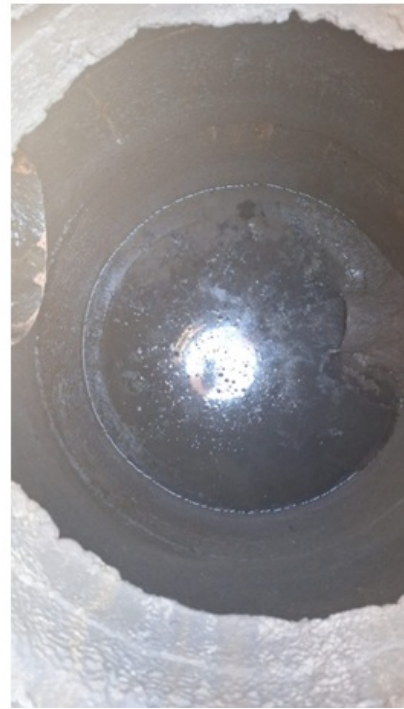
Foto 2 e 3 – Vista de PV's ( poços de visita) , onde o primeiro na Rua Dom Manuel encontra-se cheio; e o segundo na esquina com a Av. da Liberdade trata-se de rede interceptora que opera afogada ao nível do canal deste logradouro, captando seus despejos em tempo seco e os despejos da rede coletora, onde observamos que neste momento não havia vazão.
