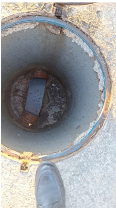
Foto 15 e 16 – PV's do coletor da Rua José Pinto de Macedo que tem destino na EEE APAE (na calha, ou seja, sem obstrução). Estes foram executados sem almofada, e a tubulação apenas foi cortada na geratriz superior (fora do padrão).
