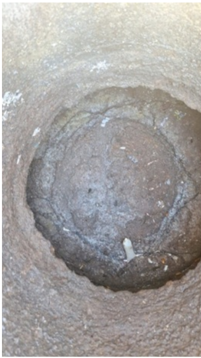
Foto 2 e 3 – Vista de PV's ( poços de visita) , onde o primeiro na Rua Dom Manuel encontra-se cheio; e o segundo na esquina com a Av. da Liberdade trata-se de rede interceptora que opera afogada ao nível do canal deste logradouro, captando seus despejos em tempo seco e os despejos da rede coletora, onde observamos que neste momento não havia vazão.
