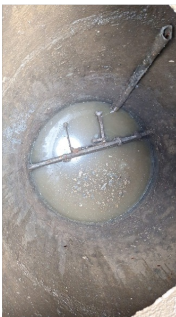
Foto 4 – Poço com gradeamento .
