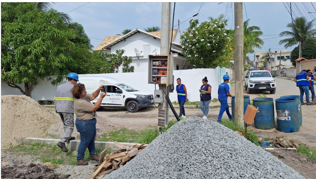
Foto 2 – Vista da EEE Monte Alto 4 (esquina das Ruas das Flores e da Alegria).
