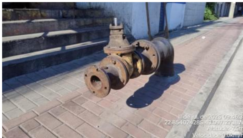
Foto 08 – Tubulação situada no centro do passeio
