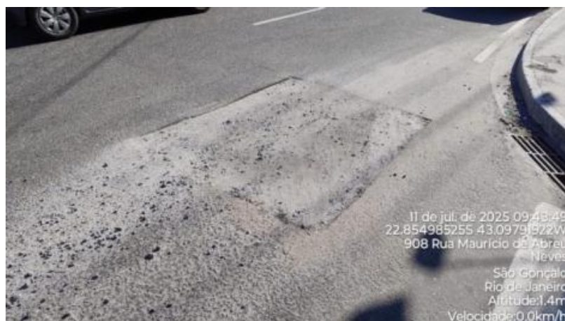
Foto 04 – Recomposição Inadequada
