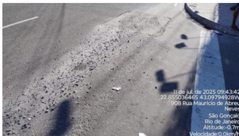
Foto 03 – Recomposição Inadequada
