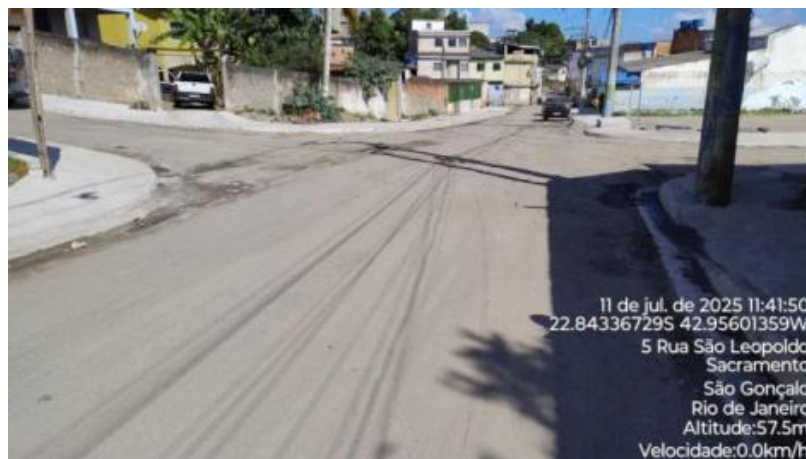
Foto 18 – Obras em fase de finalização no bairro Sacramento
