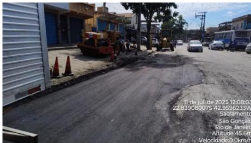
Foto 19 – Obra de recapeamento efetuada pela prefeitura
