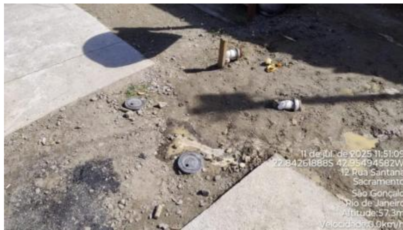
Foto 17 – Obras em andamento
