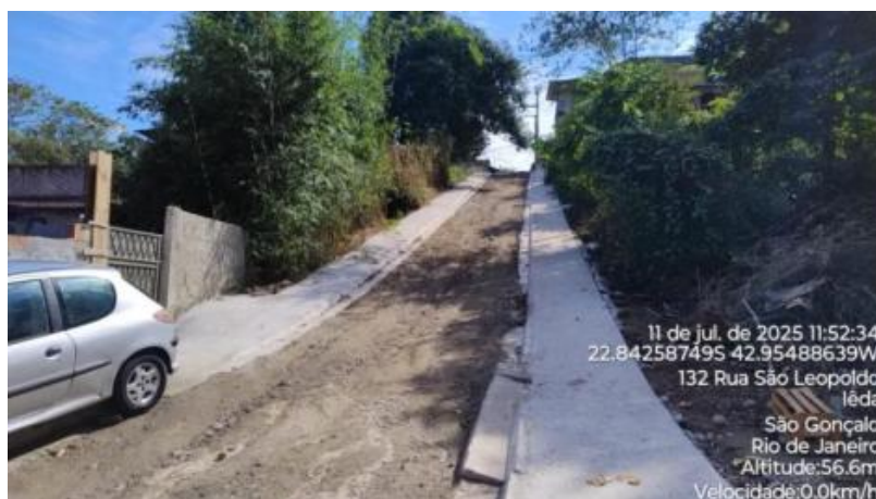
Foto 16 – Obras em andamento no bairro Iêda
