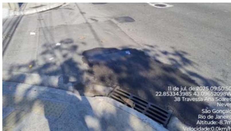
Foto 11 – Intervenção efetuada de forma adequada
