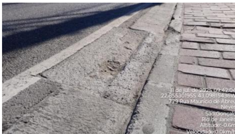
Foto 01 – Correção feita na rua Mauricio de Abreu, 779
