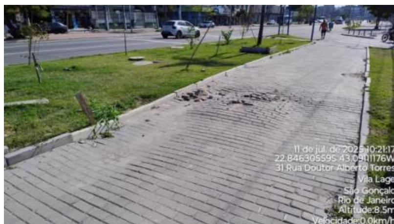
Foto 13 – Passeio com diversas incorreções
