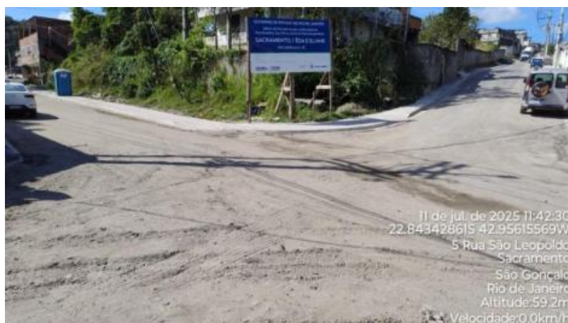
Foto 15 – Obras em andamento no bairro Sacramento
