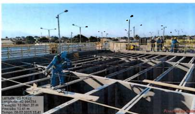
Foto 49: Floculador da ETA 3 com obras em andamento.
