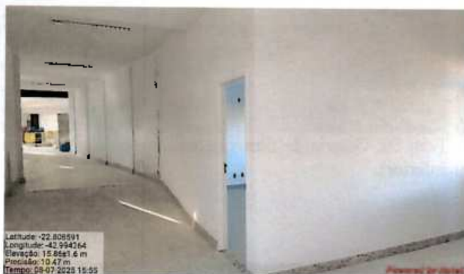
Foto 51: Galeria superior dos filtros.
