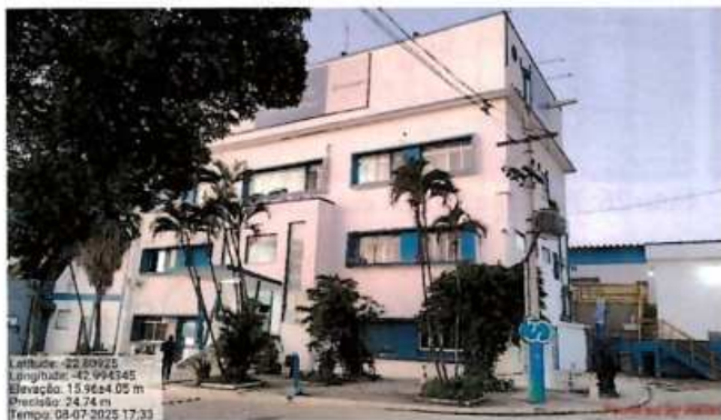
Foto 29: Prédio principal da ETA.
