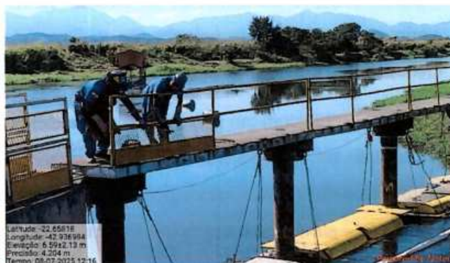
Foto 6: Manutenção sendo realizada em guarda-corpos.
