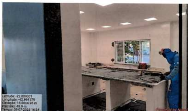
Foto 84: obras de expansão do laboratório de cromatografia.
