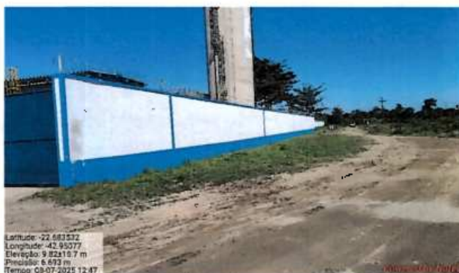
Foto 16: Obra de conclusão do muro.
