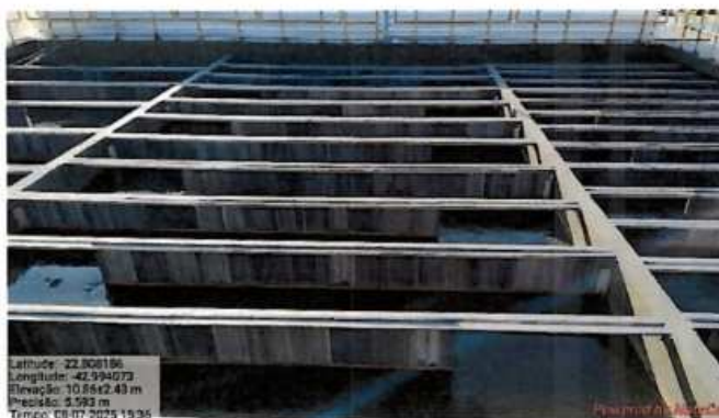
Foto 47: Floculador da ETA 3 com obras concluídas.
