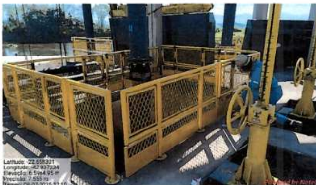
Foto 5: Manutenção sendo realizada em guarda-corpos.
