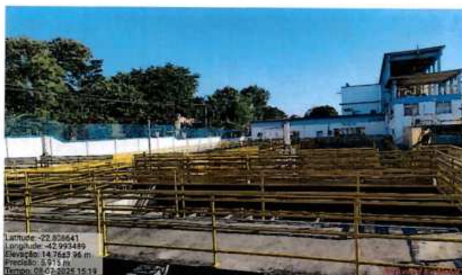
Foto 39: Vista da ETA 1.
