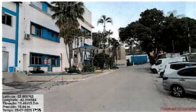
Foto 30: Pátio interno da ETA.
