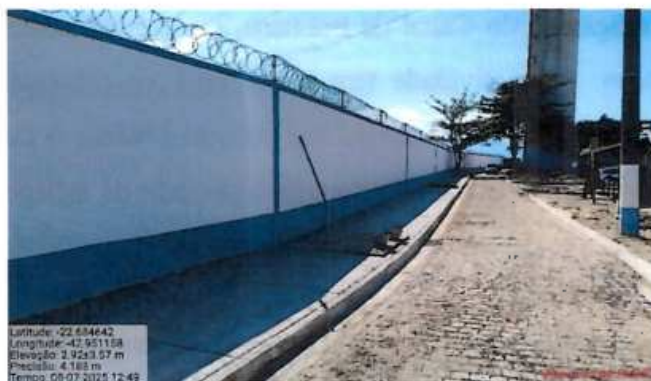
Foto 17: Obra de conclusão do muro.
