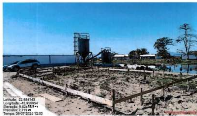
Foto 20: Obra para construção galpão para abrigar unidade de carvão ativado.
