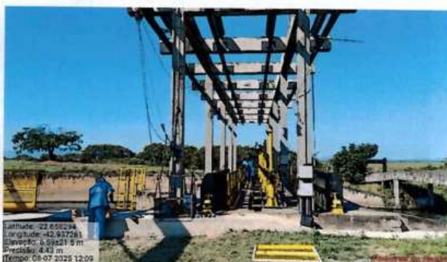
Foto 4: Unidade de captação. Manutenção sendo realizada em guarda-corpos.
