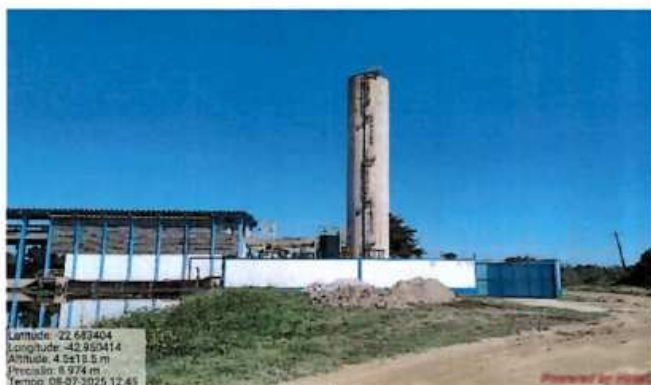
Foto 15: Estação elevatória de água bruta.
