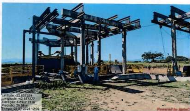
Foto 3: Unidade de captação. Manutenção sendo realizada em guarda-corpos.
