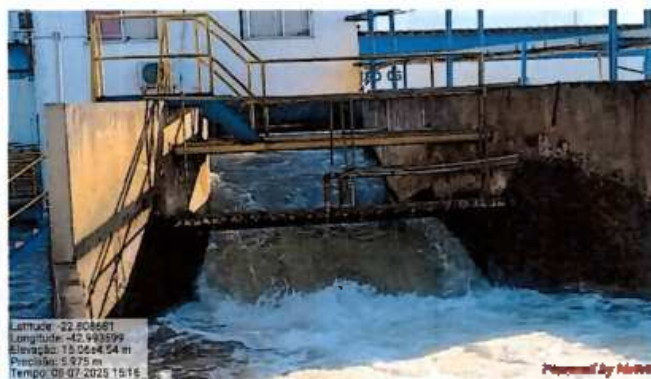
Foto 38: Aplicação de coagulante sulfato de alumínio.
