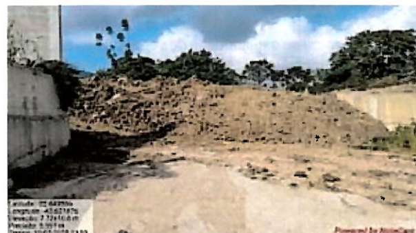
Foto 22: Constatou-se a quantidade de resíduos retirado do canal após alargamento do desvio.
