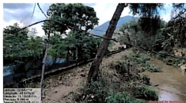
Foto 12: Vista a jusante do canal velho com extensa vegetação.
