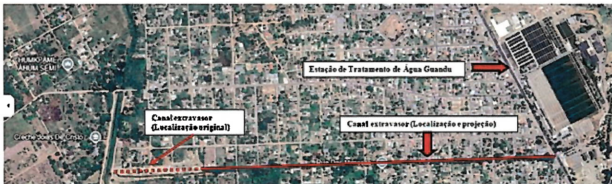
Imagem 2: Extensão do canal extravasor (imagem Google Earth em 02/03/2025 capturada em 15/07/2025).
