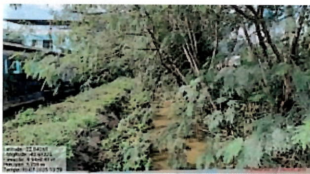
Foto 16: Observou-se a quantidade de vegetação invasora no leito do canal a montante.
