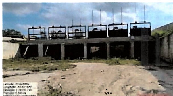
Foto 21: Vista das galerias do galpão do Sistema de Tratamento de Resíduos em construção pela CEDAE.
