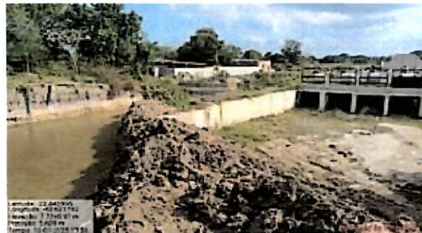
Foto 20: Vista do desvio do canal e vista das galerias do galpão do Sistema de Tratamento de Resíduos em construção pela CEDAE.
