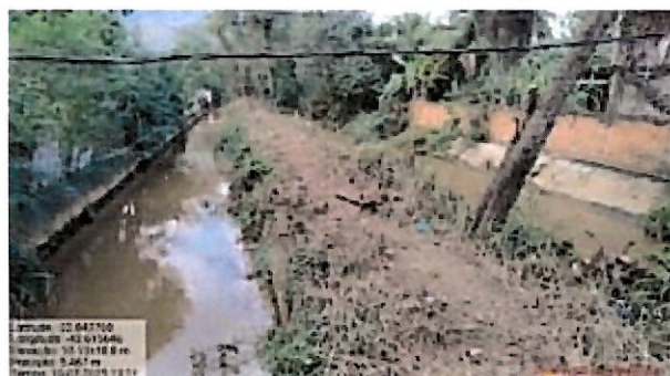
Foto 8: Vista a jusante dos canais novo e velho.
