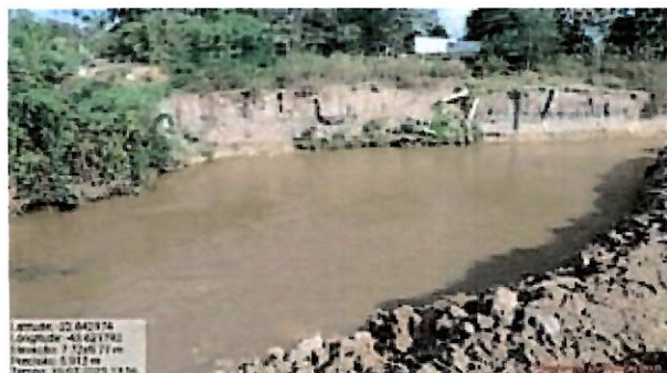
Foto 18: Constatou-se que houve um alargamento no desvio após o transbordamento do canal.
