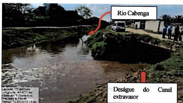
Foto 25: Ponto de deságue do canal no Rio Cabenga
