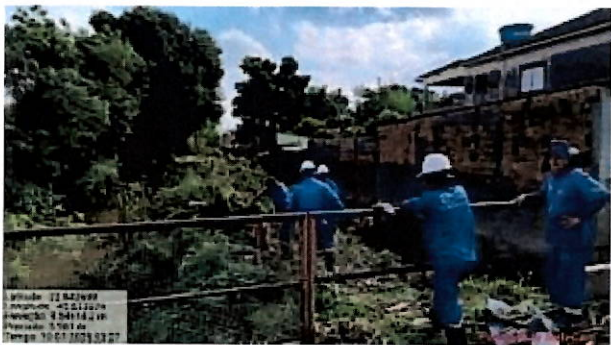
Foto 13: Observou-se que a CEDAE iniciou a supressão de parte da vegetação invasora no leito do canal a jusante.
