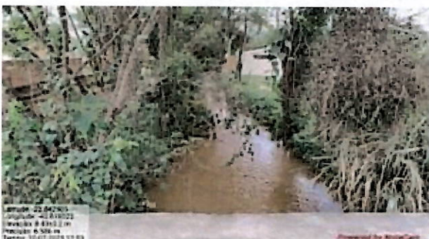
Foto 3: Vista a montante do canal extravasor "velho".
