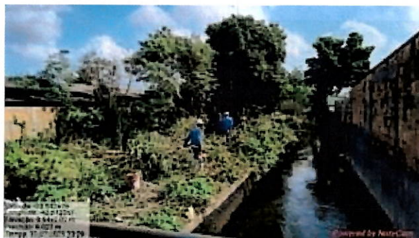
Foto 14: Observou-se que a CEDAE iniciou a supressão de parte da vegetação invasora no leito do canal a jusante.
