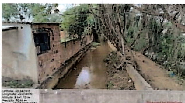
Foto 4: Vista a montante do canal extravasor "novo".
