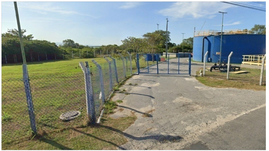
Foto 2 –Vista da entrada da ETE.
