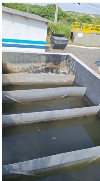
Foto11 –Câmara de contato de cloração (para desinfecção).
