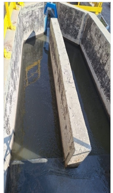
Foto 4 – Gradeamento fino ( limpeza
