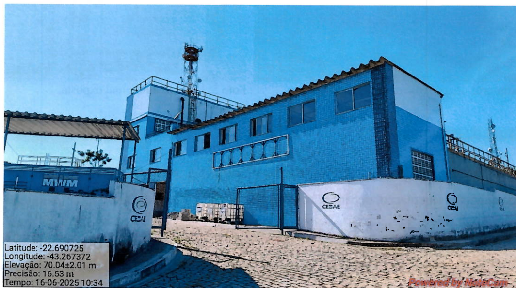
Foto 1: Fachada da ETA (ausência de placa de identificação).
