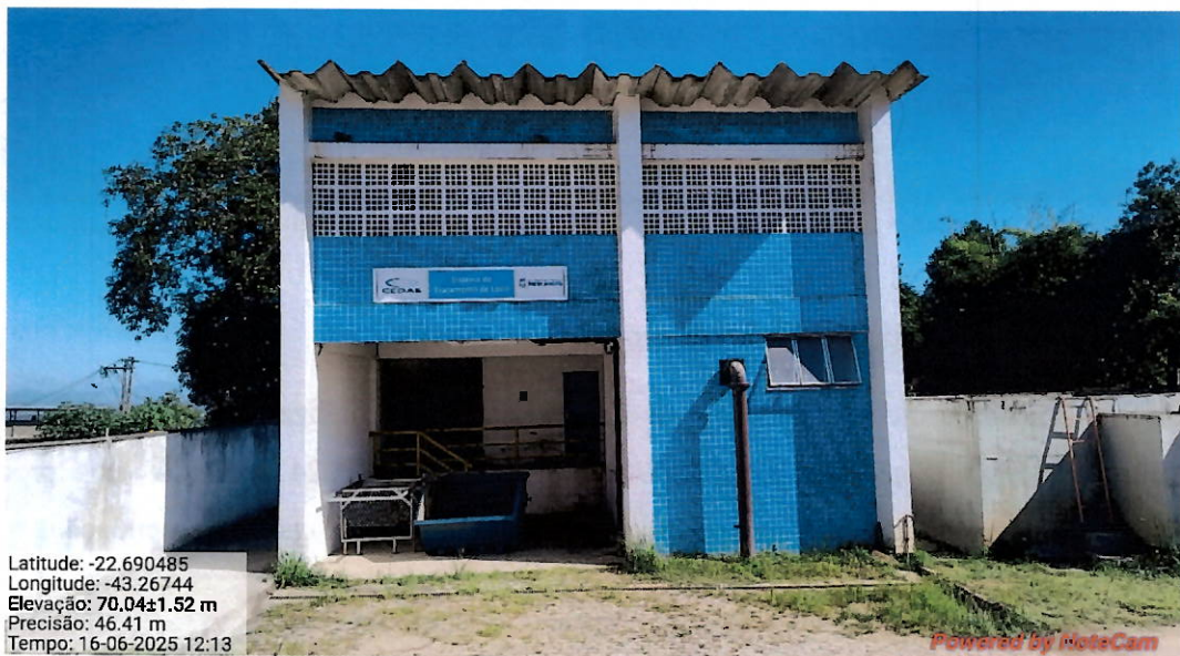
Foto 32: Unidade de tratamento de lodo.
