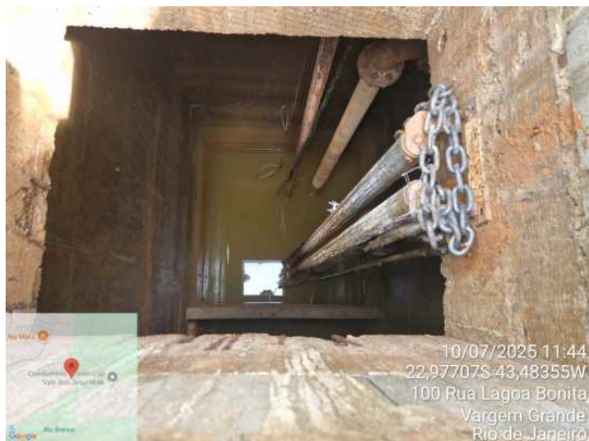
Foto 5 – Poço das motobombas
