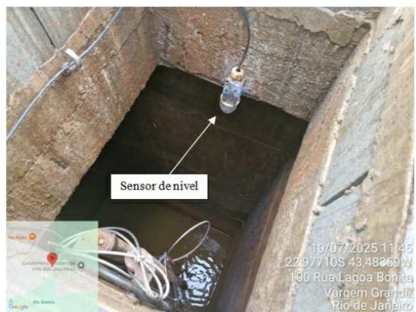
Foto 6 – Poço das motobombas
