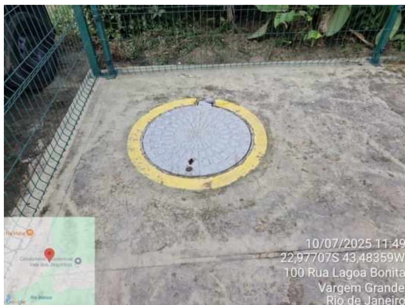
Foto 8 – Tampão ca caixa de chegada do esgoto
