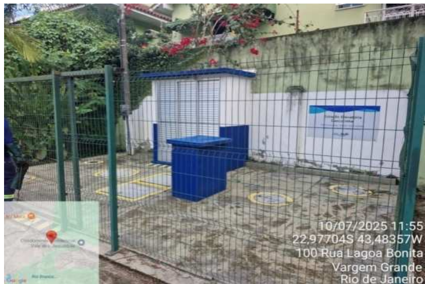
Foto 1 – Vista da EEEB
