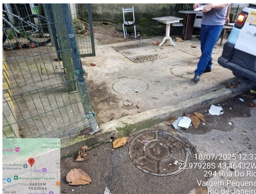
Foto 10 – Tampão do PV onde está a tubulação extravasora
