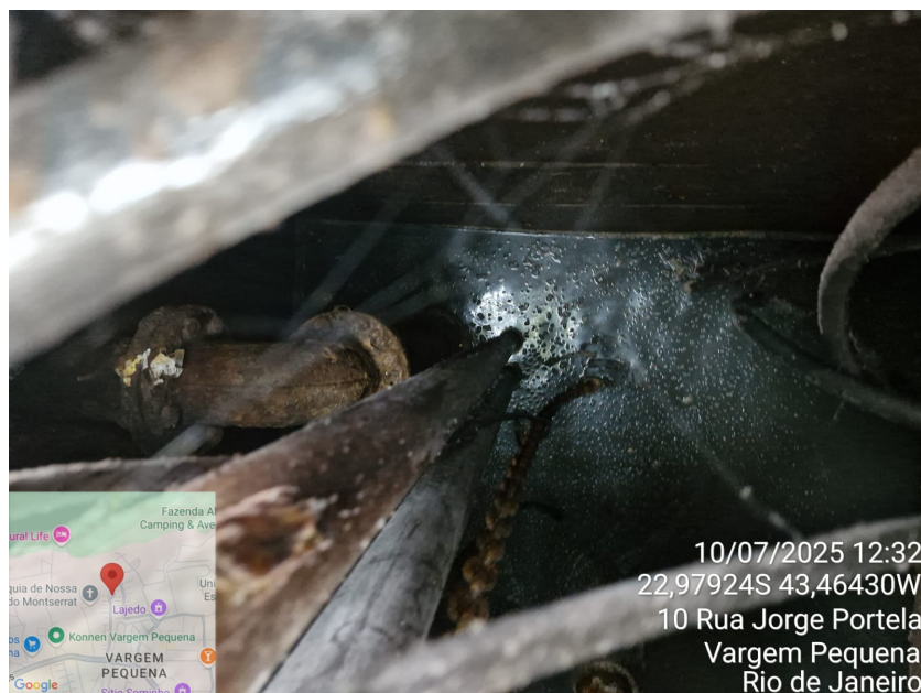
Foto 5 – Poço das motobombas
