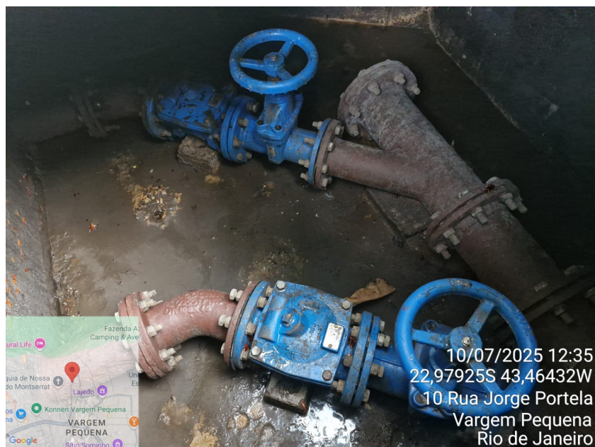
Foto 11 – Tubulação de recalque
