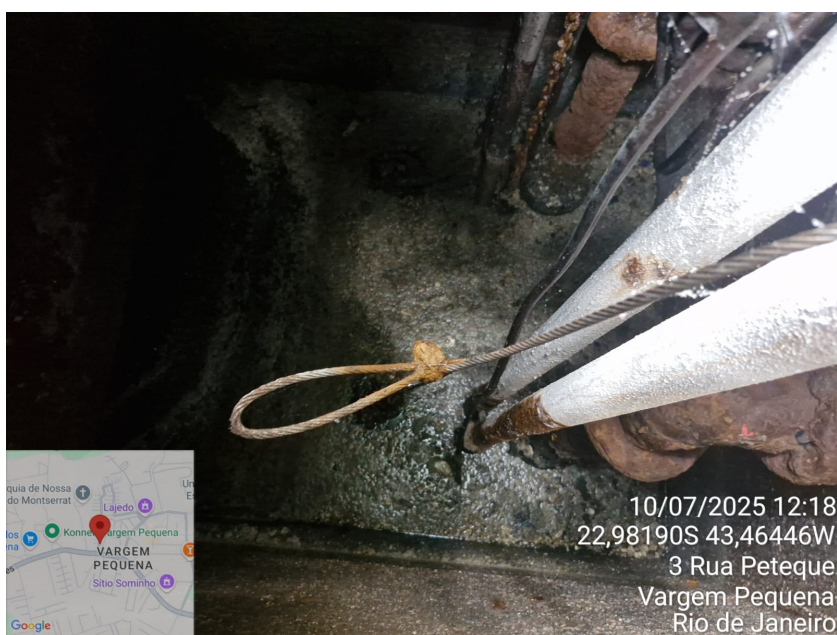
Foto 6 – Poço das motobombas
