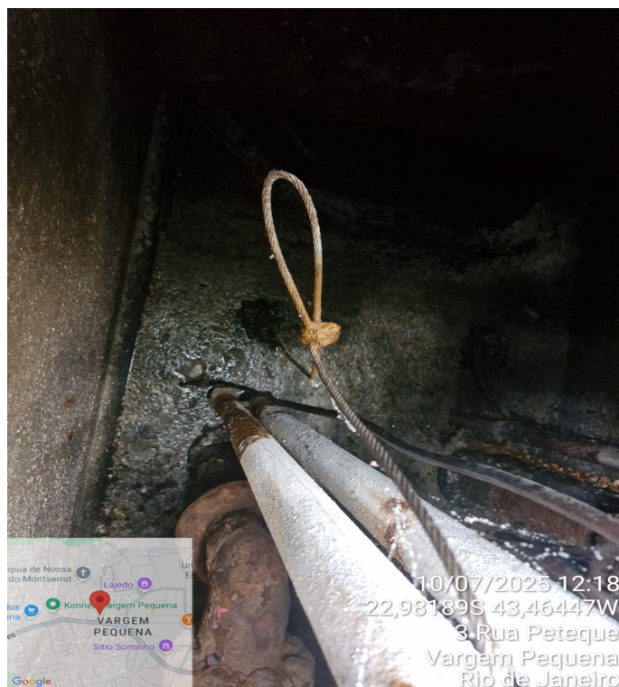
Foto 7 – Poço das motobombas
