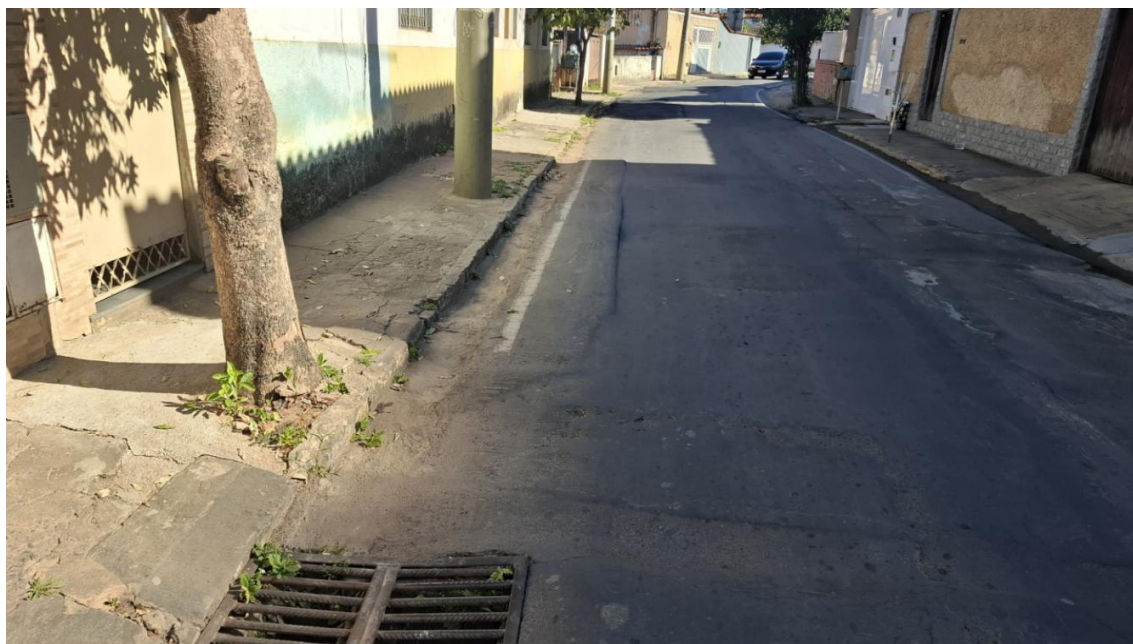
Foto 04 - Rua Rangel Pestana; outro trecho recomposto
