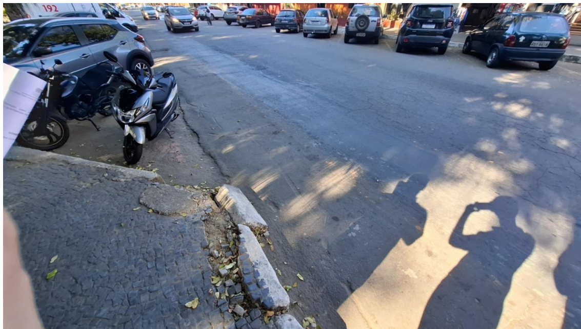
Foto 01 - Av. Marechal Castelo Branco; trecho recomposto
