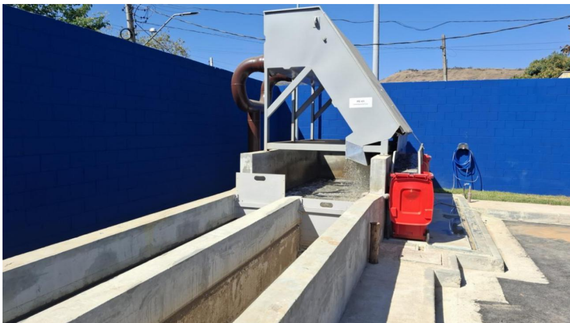
Foto 03 - Peneira estática para remoção de sólidos
