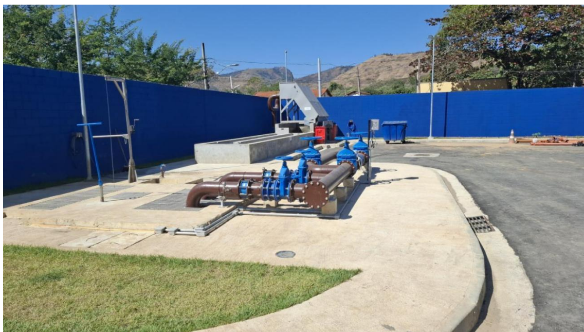
Foto 02 - Elevatória da estação
