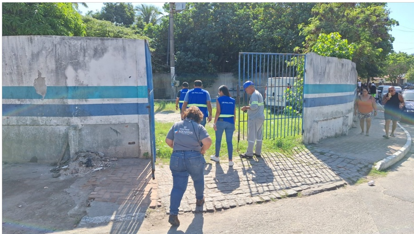
Foto 2 – Vista da entrada da EEE APAE/ Parque Público.
