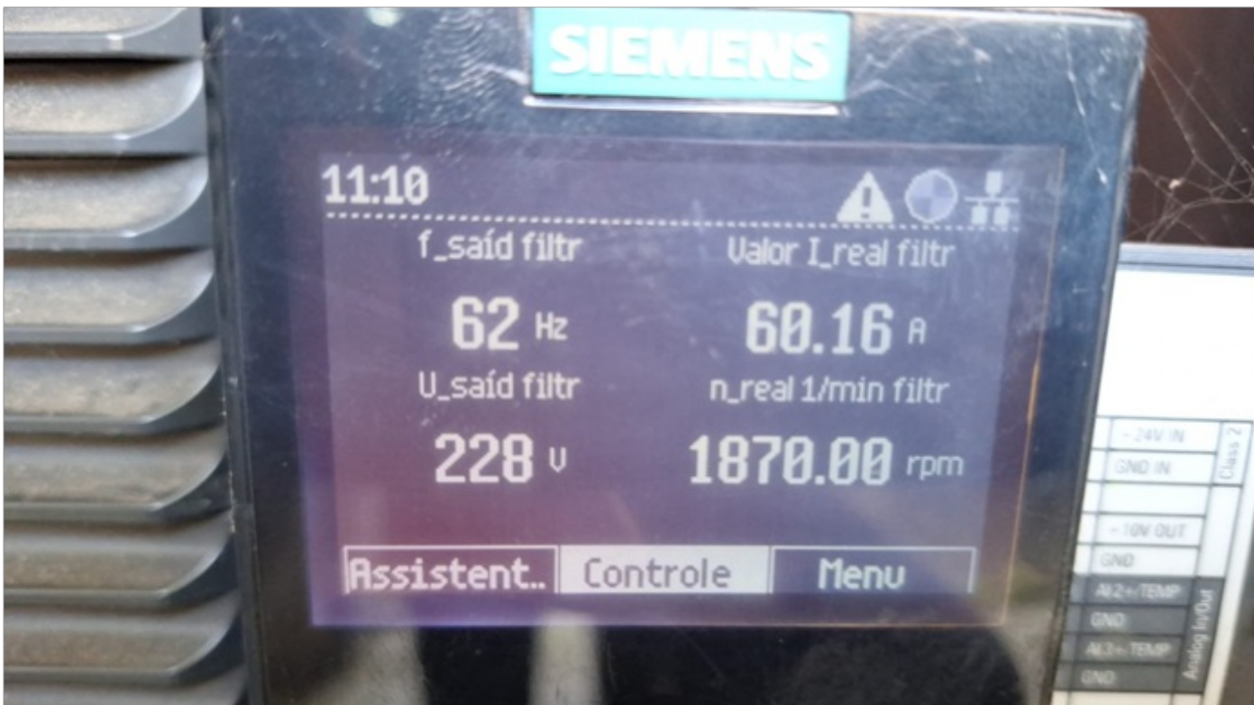
Foto 5 – Medidor do inversor de frequência sinalizando :
