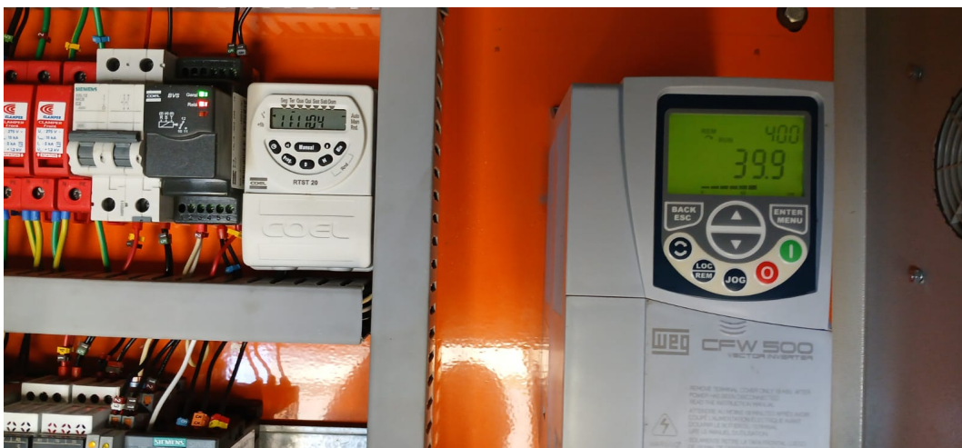
Foto 4 – Pressão de recalque da unidade
