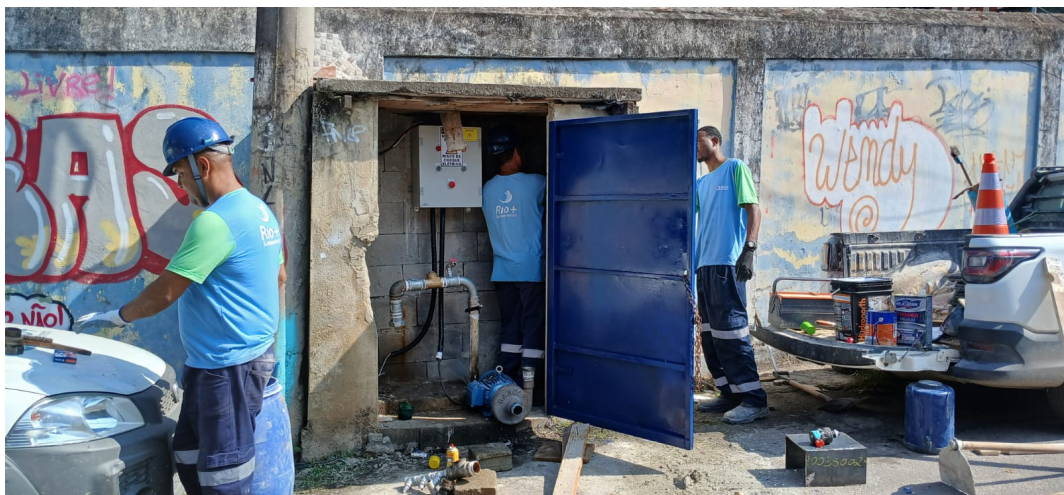
Foto 1 – Visualização da unidade em manutenção
