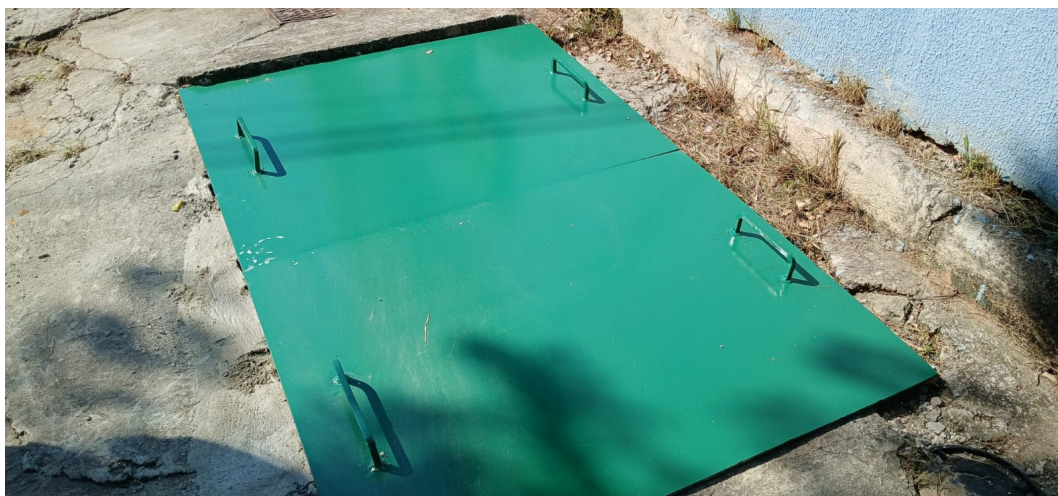
Foto 1 – Visualização das tampas do abrigo subterrâneo
