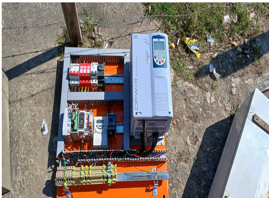
Foto 3 – Novos equipamentos que serão instalados no painel de automação
