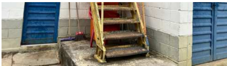
Foto 5 Escada de acesso ao tratamento
