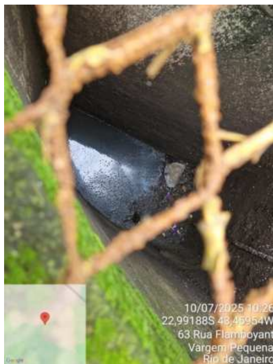
Foto 02 – Poço de sucção
