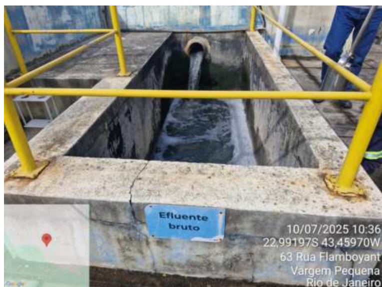
Foto 08 – caixa de distribuição
