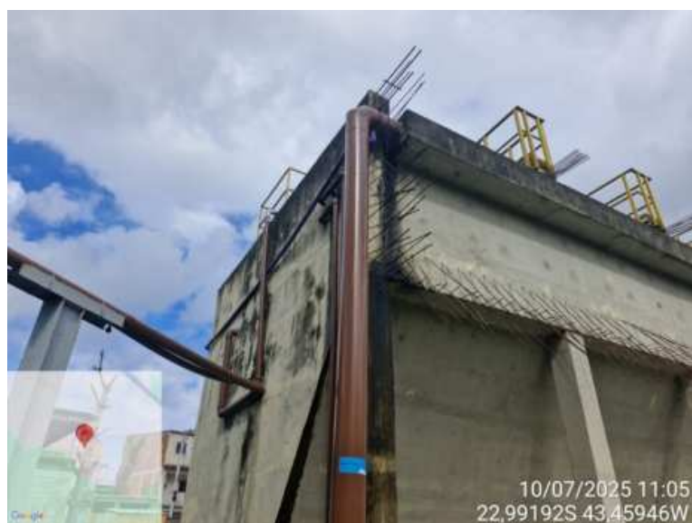
Foto 14 – saída do efluente tratado
