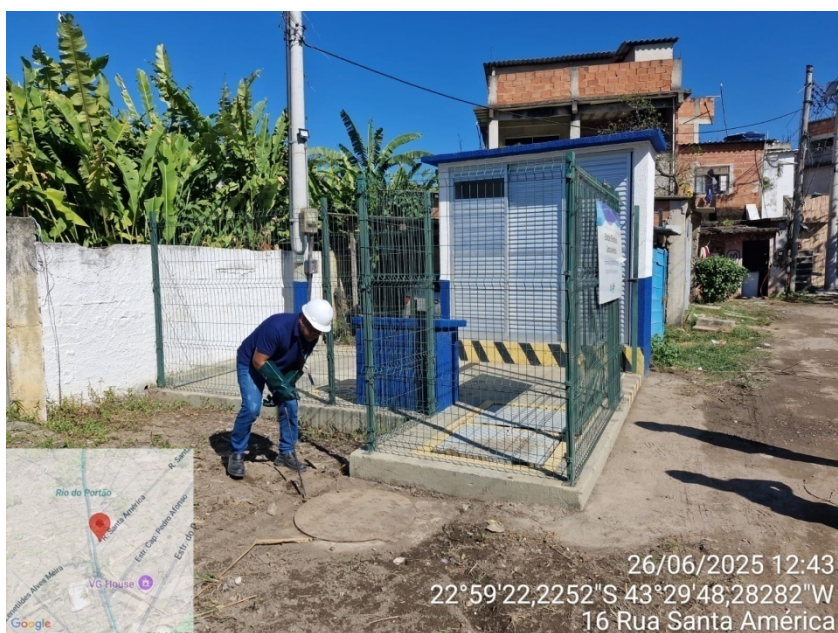
Foto 2 – Tampão da caixa receptora do esgoto
