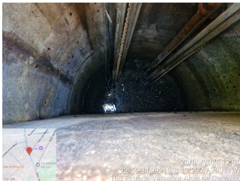
Foto 3 – Poço das Motobombas
