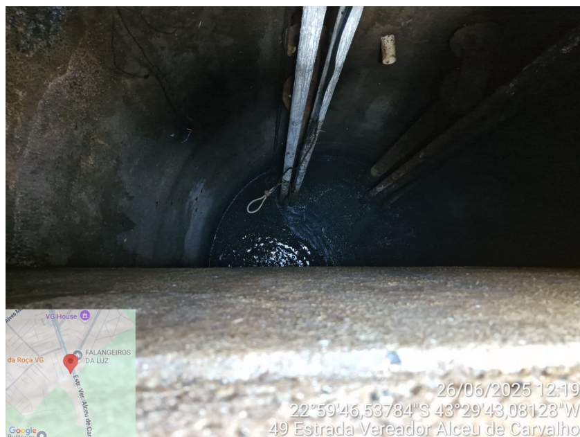
Foto 3 – Poço das motobombas
