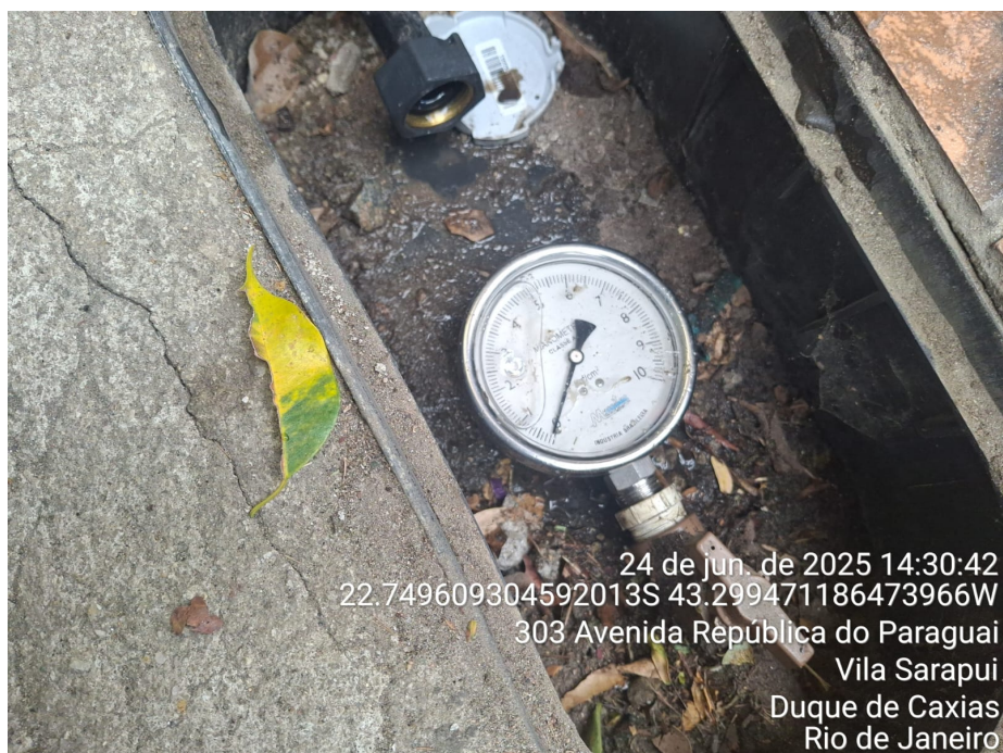
Foto 3. Manômetro no hidrômetro da usuária.
