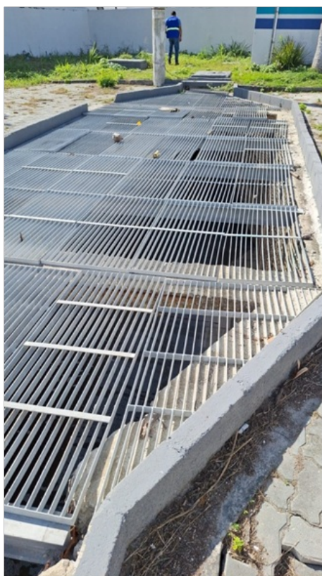
Foto 5 – Tampa gradeada do poço da EEE Teatro
